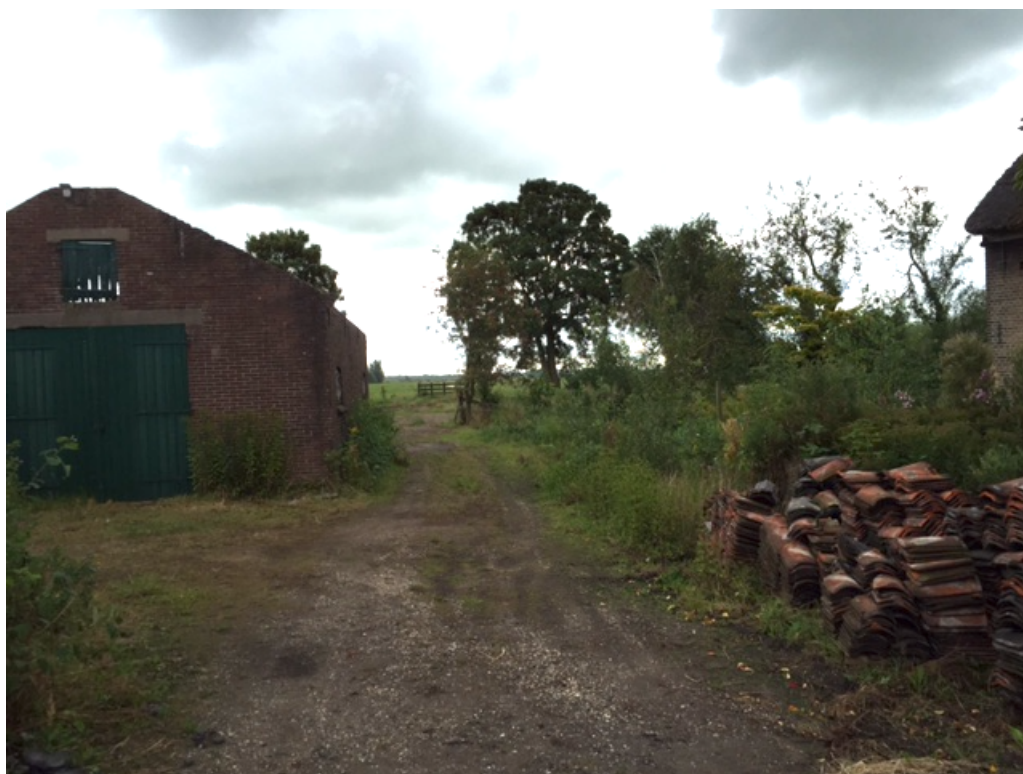
Figuur 2 De stallen en/of schuren verkeren in een bouwvallige staat. Het terrein tussen de bebouwing is verhard met grind, asfalt en beton.
