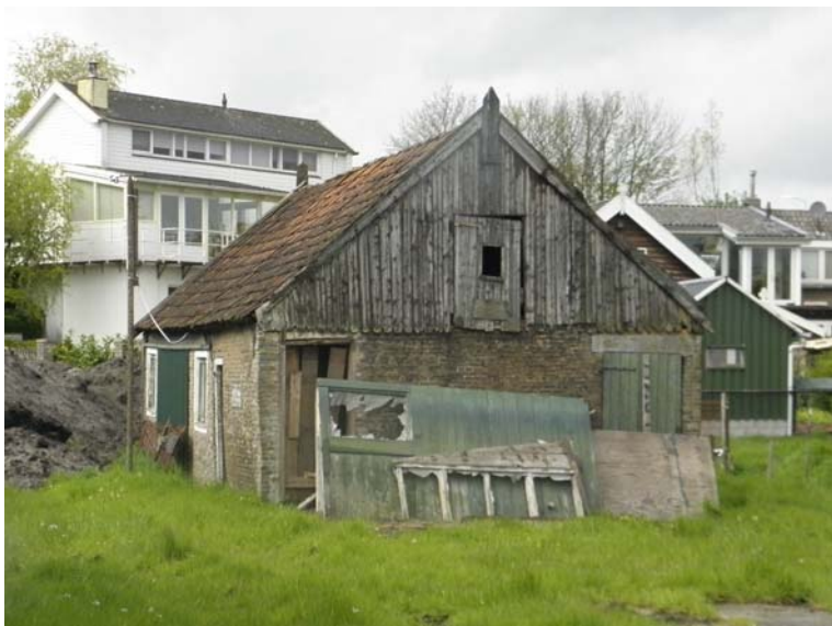
De rechthoekige schuur met houten topgevel. Tegen deze zijde van de schuur bevond zich een afdakje.
