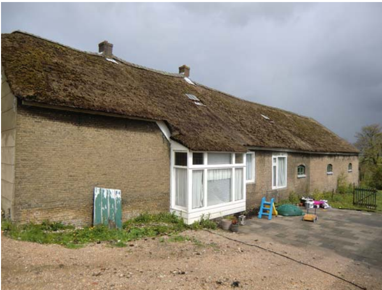
Het zadeldak van de boerderij. Aan de rechter zijde bevinden zich twee dakramen van gietijzer in het dakvlak. Het rieten dakvlak is over de later uitge- bouwde erker doorgetrokken.
