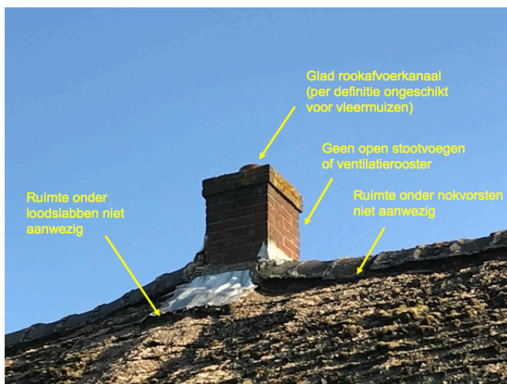
Figuur 2 De schoorstenen, nokvorsten en loodslabben zijn niet toegankelijk voor vleermuizen. De aanwezigheid van vaste rust- en verblijfplaatsen is derhalve uitgesloten.
