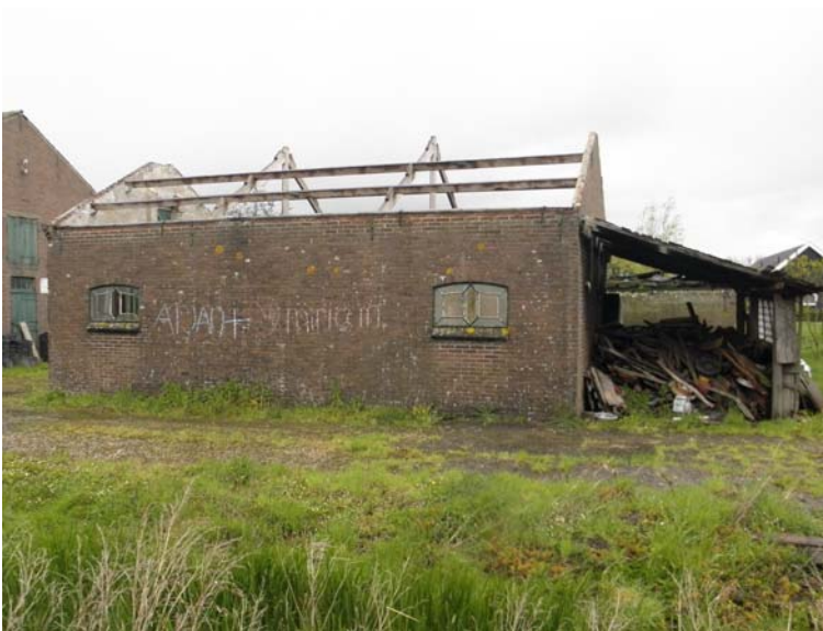
De rechter zijgevel met twee gietijzeren stalramen.
