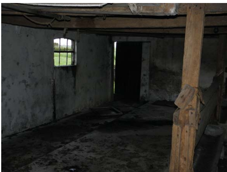
Het interieur van de schuur met koeienstal. Houten stijlen ondersteunen de enkelvoudige balklaag.
