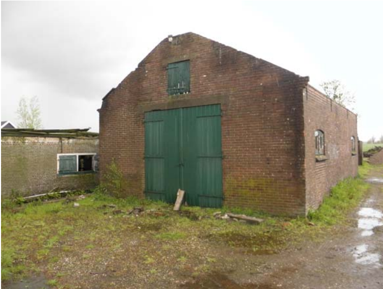
De voorgevel van de schuur met de dubbele inrijdeuren en daarboven het hooiluik.
