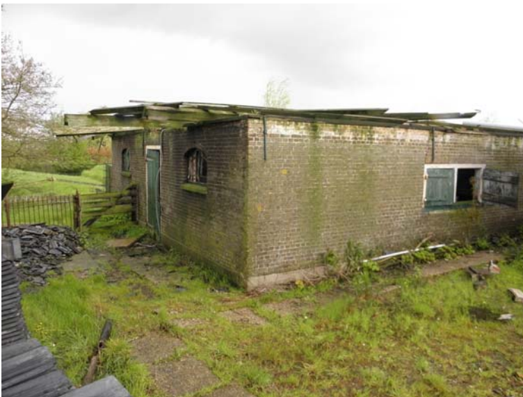
De voorgevel met stalvensters van gietijzer en de rechter zijgevel met dubbele houten mestluiken.
