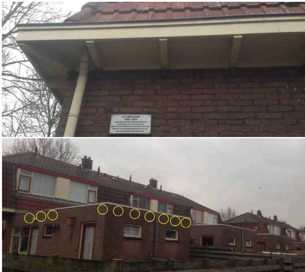
Figuur 2 De brede goten en de afwerking belemmeren de toegang voor vleermuizen onder het dak. Behoudens enkele open stootvoegen in de aanbouw is de spouw niet toegankelijk voor vleermuizen (foto: woning Kerkweg 91).
