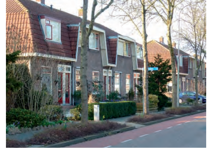
15. Ritme in dak en gevels: puntgevels, dakkapellen, entrees, schoorsteen.
