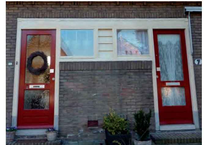
18 Houten detaillering potdeksel bij de entree en dakgoten.
