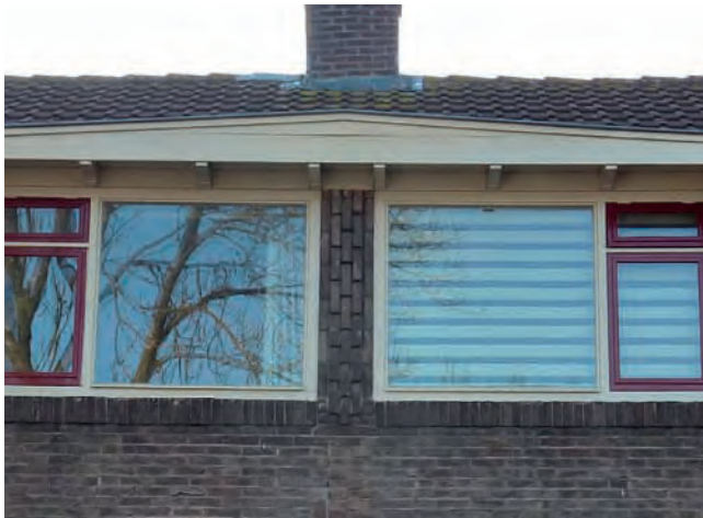
16. Ambachtelijkheid: metselwerk en details.
