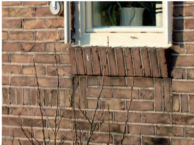
17. Verschillende metselwerkverbanden: band in de plint en de onderdorpels.
