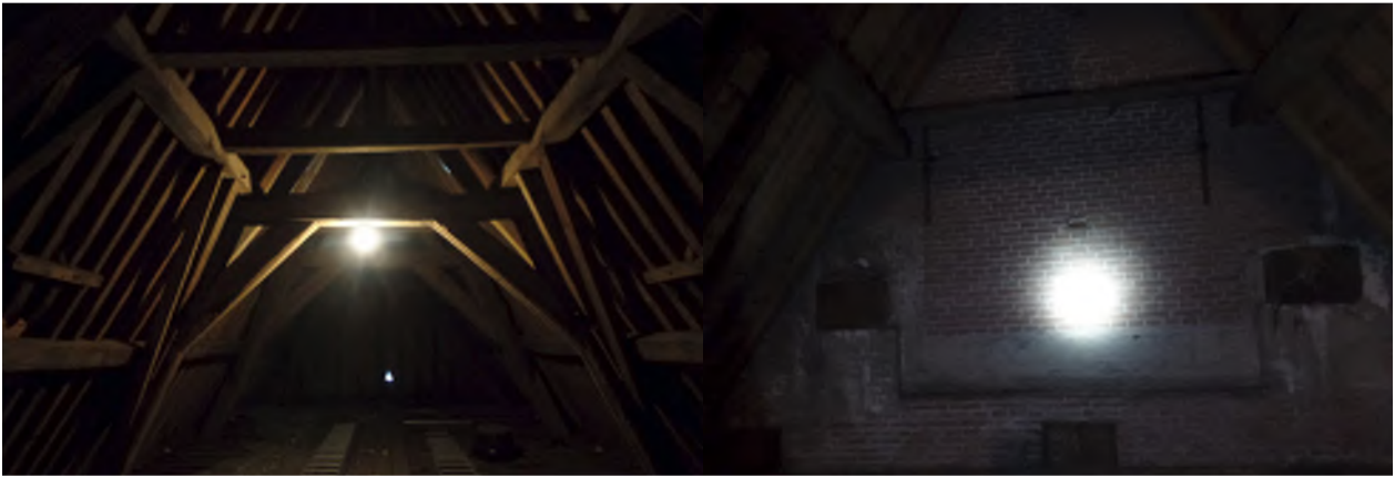
Afbeelding 11 en 12: inspectie van het kerkgebouw, er werden geen indicatoren gevonden die wijzen op mogelijk gebruik door vleermuizen.
