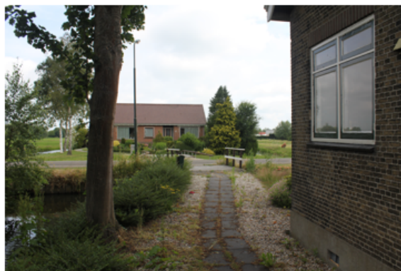
De oprit naast de bestaande woning.
