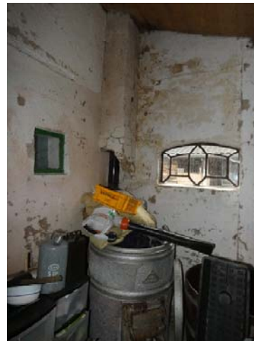
In de zuid/west hoek is het rookkanaal aanwezig met daaronder het waterfornuis.
