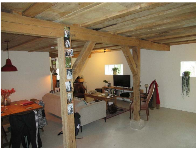
De oorspronkelijke gebintconstructie op de begane grond.
