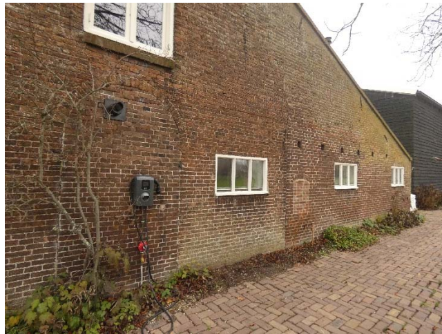
De verlenging is nog goed zichtbaar in het metselwerk.
