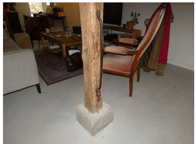
Aan één van de gebintstijlen is nog een metalen staaf aanwezig waaraan de koeien gebonden werden.
