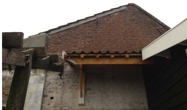
De rechter zijgevel is maar voor een klein gedeelte zichtbaar. Ook hier is in het metselwerk de uitbreiding goed terug te zien.
