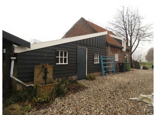
Aan de linkerzijde bevindt zich een houten uitbouw die van oorsprong gemetseld is geweest.
