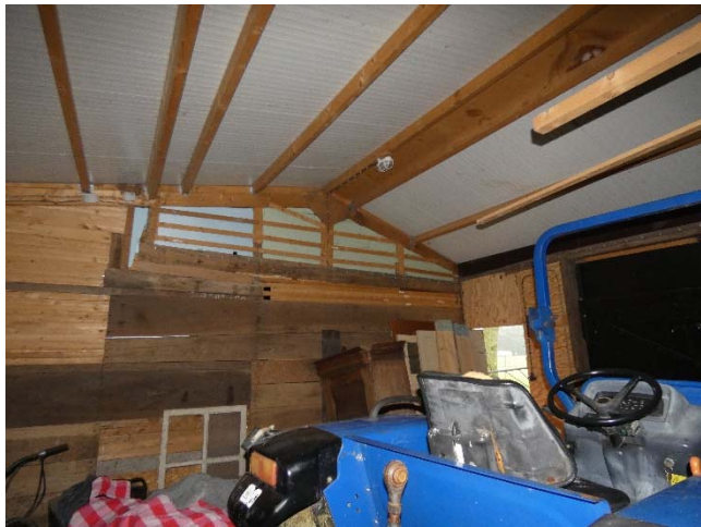
In het achterste deel van het schurencomplex is een wagenschuur/garage aanwezig. Deze schuur stamt uit de tweede helft van de twintigste eeuw.
