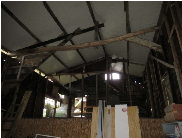
Het interieur van de hoge houten schuur, gezien richting de achterzijde van het perceel.
