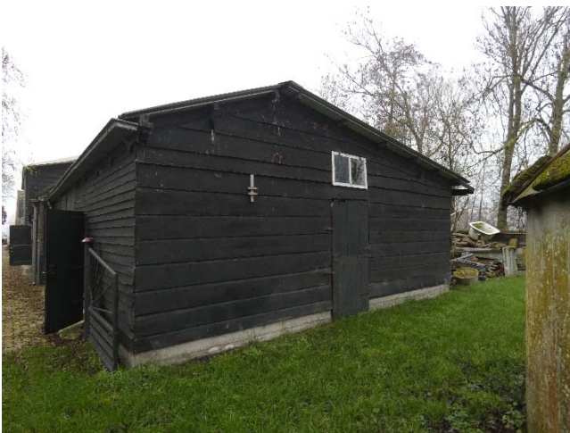
Achterzijde van het schurencomplex.
