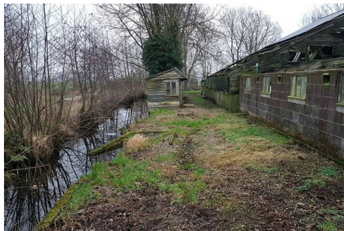
Foto 4: noordwestzijde planlocatie / voormalige varkensstal
