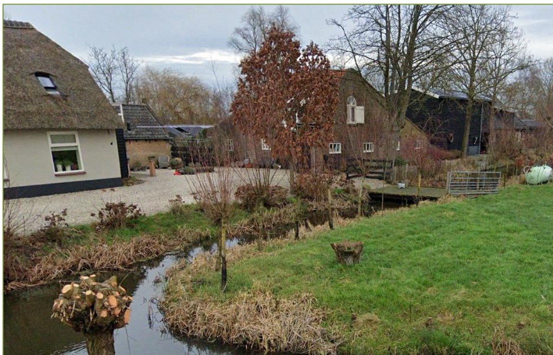
Foto 7: een beeld vanaf de Bonrepas. Links het woonhuis op het voorerf. Rechts de stenen schuur die wordt gerenoveerd en aansluitend de houten schuur.
