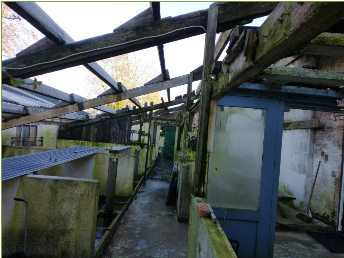
Foto 4: de voormalige varkensschuur.
