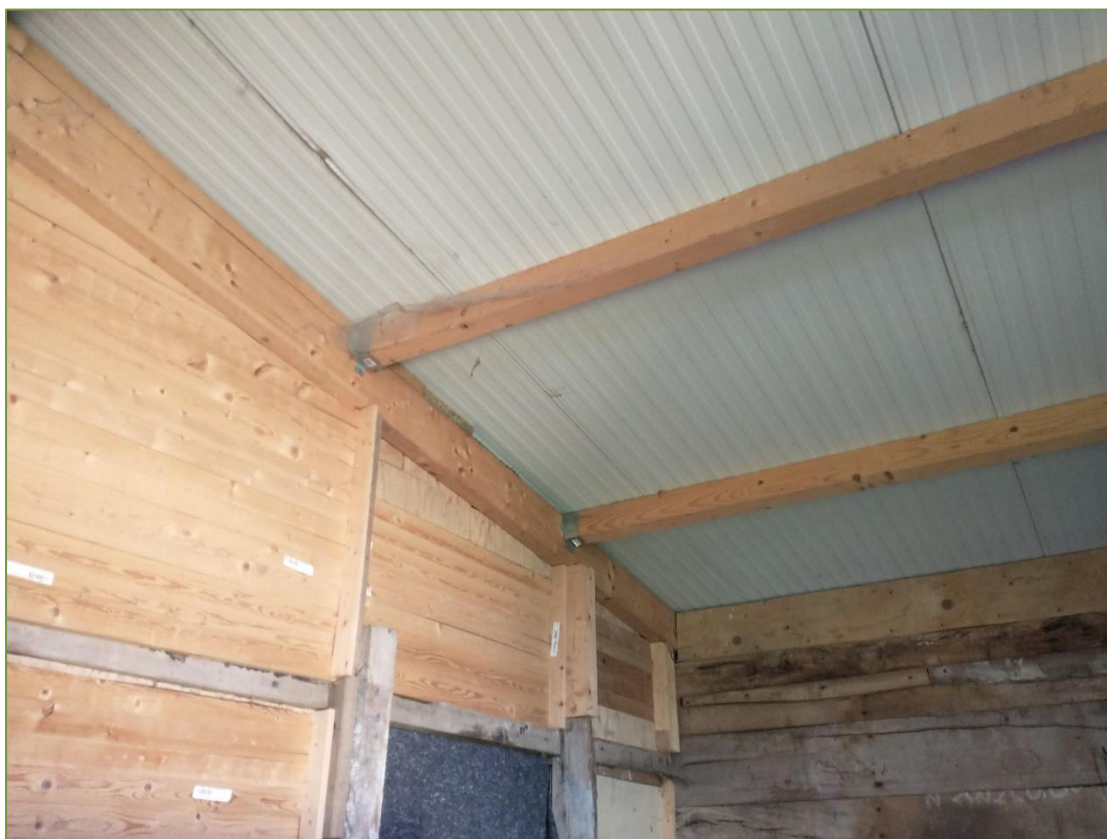
Foto 2 de hoge schuur aan de binnenzijde. De golfplaten (en zijwanden) zijn ook hier zichtbaar en niet afgetimmerd.
