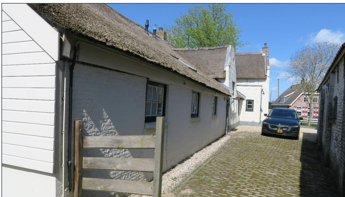
Figuur 2 De bebouwing bestaat uit de woonboerderij (links) en twee stalgebouwen (rechts zicht op een van de stalgebouwen).
