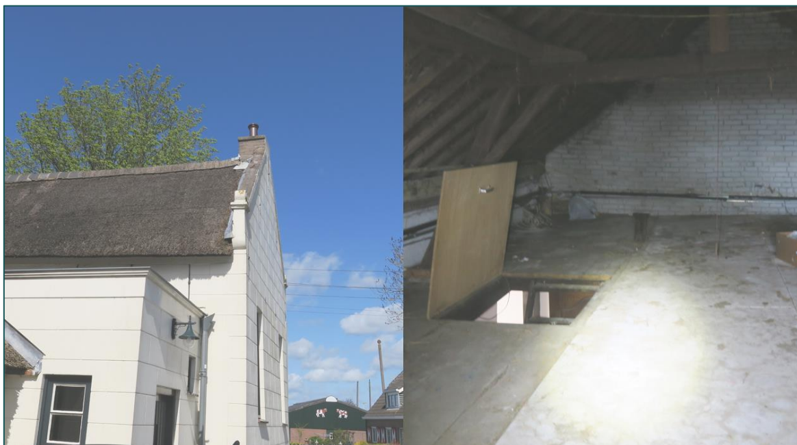
Figuur 3.1 Zicht op de gevel en binnenzijde van de zolder aan de voorzijde van de woonboerderij.
