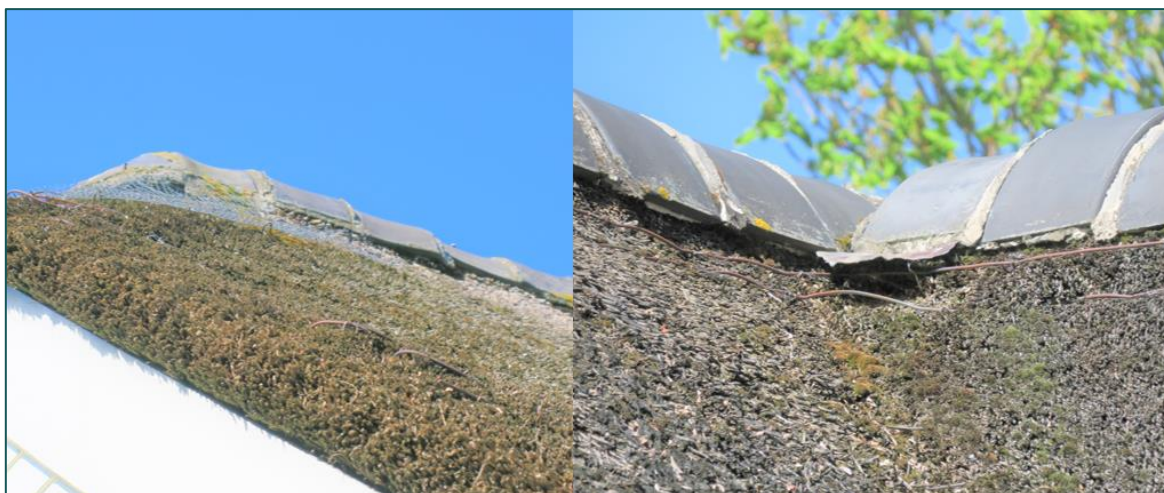
Figuur 3.4 Links: zicht op de nokvorst afgedekt met gaas aan de zuidkant van het dak. Rechts: zicht op nokvorsten aan de noordkant van het dak, waarbij zichtbaar is dat het riet volledig aansluit op de nokvorsten.
