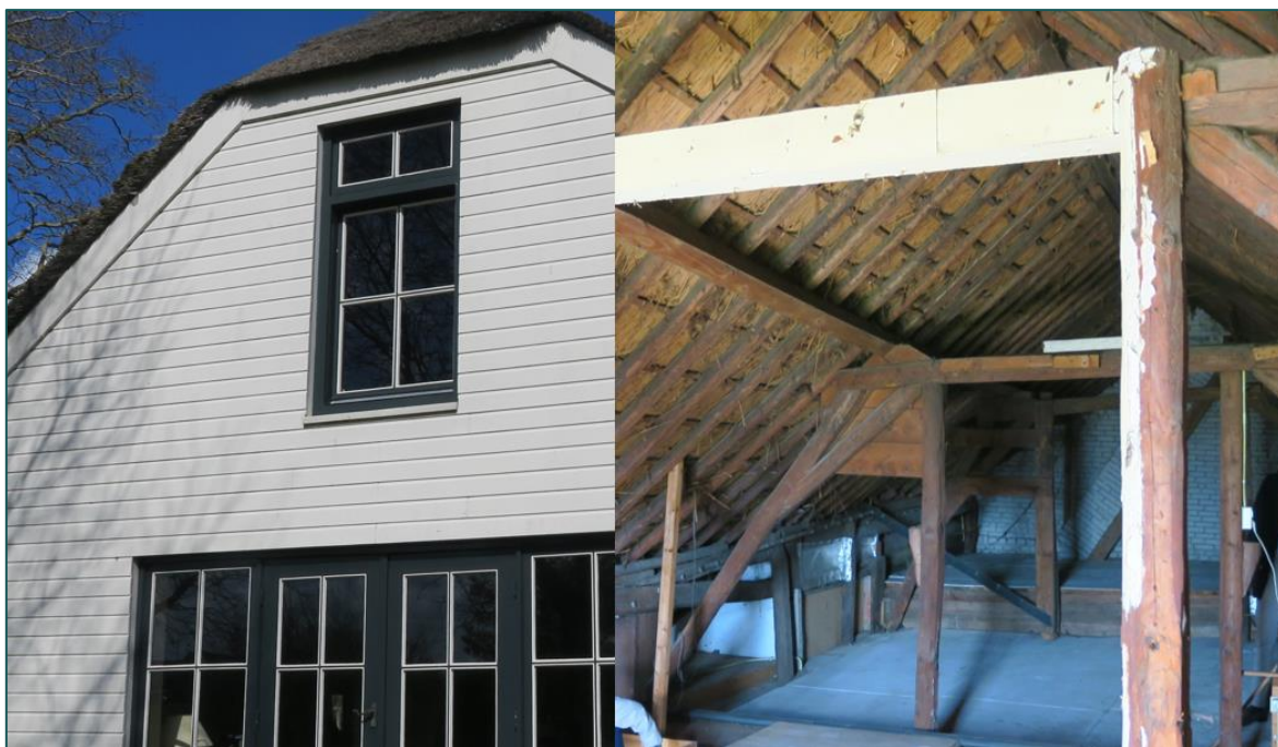
Figuur 3.2 Zicht op de gevel en binnenzijde van de zolder aan de achterzijde van de woonboerderij.
