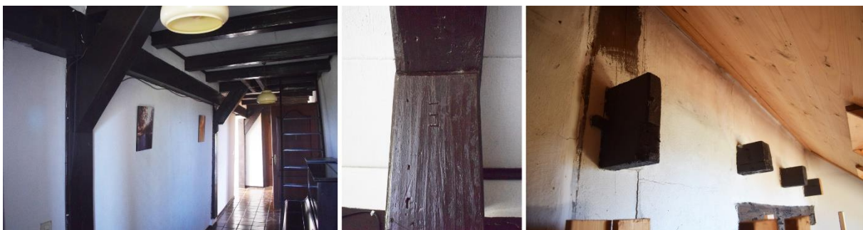
Figuur 10. Draagconstructie van het voorhuis. Links drie gebinten in de gang met op de achtergrond de brandmuur. In het midden het merktken drie op een gebintstijl en rechts twee ankerbalken in de zijbeuk met daartussen balken van de balklaag.
