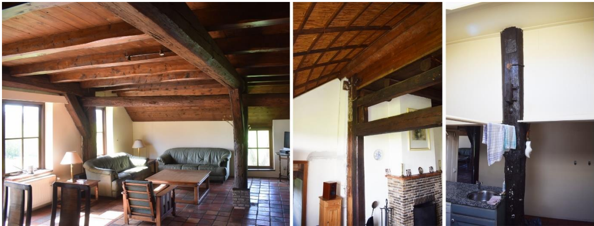
Figuur 9. De draagconstructie van het achterhuis. Links een overzicht met de twee zuidelijkste gebinten van het (voormalige) bedrijfs gedeelte. In het midden een detail van het meest noordelijke gebint van het latere woongedeelte achter de (vervallen) brandmuur. Rechts een detail van een gebint in de keuken.
