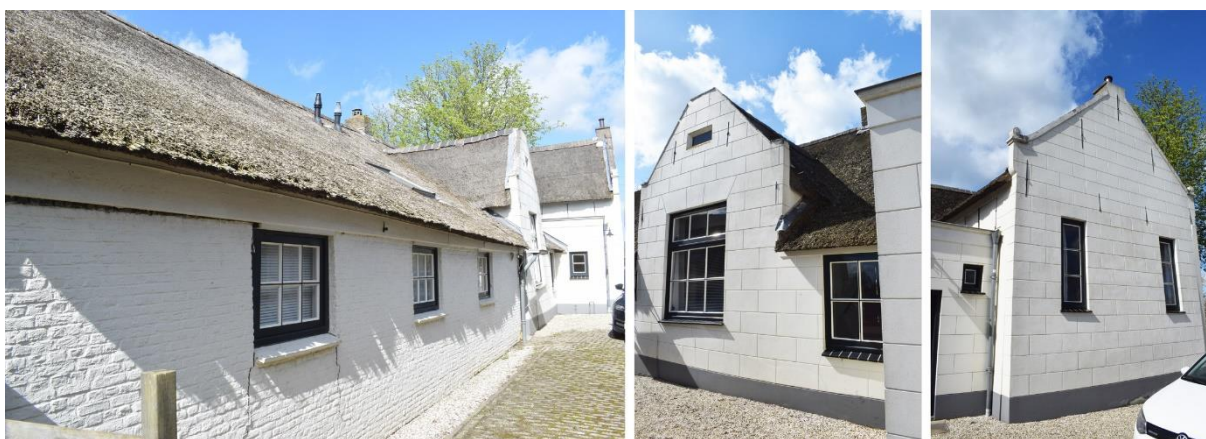
Figuur 5. De oostgevel met links het bedrijfsgedeelte, in het midden het woongedeelte van het bedrijfsgedeelte en recht de negentiende -eeuwse aanbouw.
