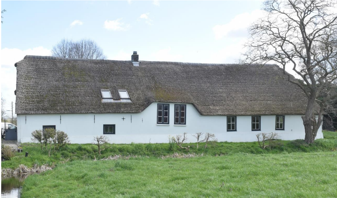
Figuur 7. De westgevel met links het voorhuis met kelder en opkamer, in het midden het woongedeelte van het bedrijfsgedeelte en rechts het bedrijfsgedeelte met de voormalige stal.
