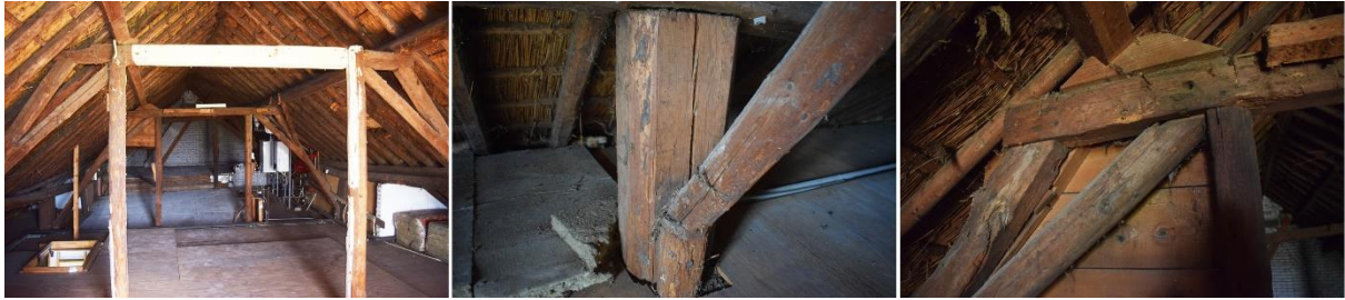
Figuur 11. Kapconstructie van het achterhuis met links een overzicht richting de brandmuur, in het midden de aansluiting van de verhoogde kap bij een ankerbalk. Rechts de aansluiting van dekbalk en korbeel van het spant.
