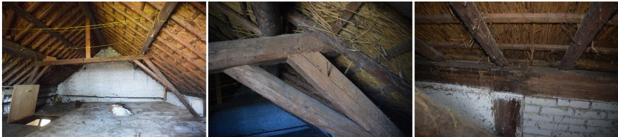
Figuur 12. Kapconstructie van het voorhuis met links zicht op de brandmuur. In het midden een detail van de spanten. Rechts de aansluiting van gebintplaat op gebint.
