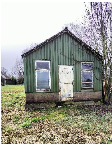
Schapenverblijf, golplaatdak, damwand gevel geen spouwruimtes.
