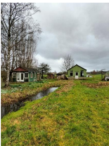
bijgebouw naast schapenverblijf, golplaat dak, houten gevels.
