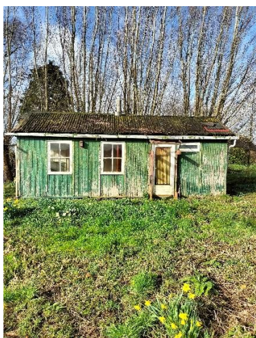
bijgebouw naast schapenverblijf, golplaat dak, houten gevels.
