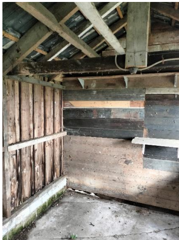
Dierenverblijf, dakpannen zonder dakbeschot, geen spouw.
