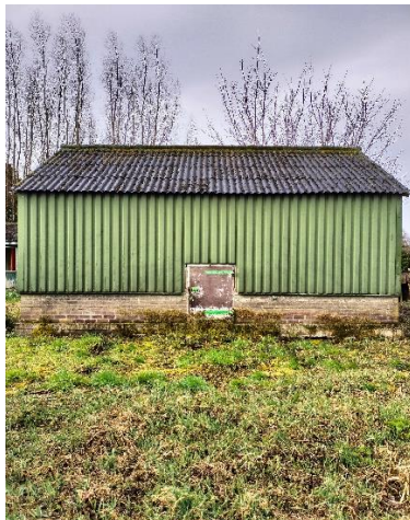
Schapenverblijf, golplaatdak, damwand gevel geen spouwruimtes.
