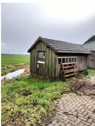
Dierenverblijf, dakpannen zonder dakbeschot, geen spouw.
