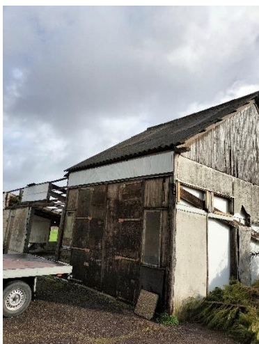
Werkplaats, golfplaat dak, afgesloten, geen spouwruimtes.
