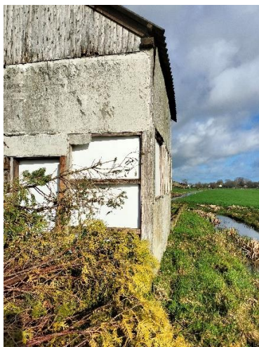
Werkplaats, golfplaat dak, afgesloten, geen spouwruimtes.
