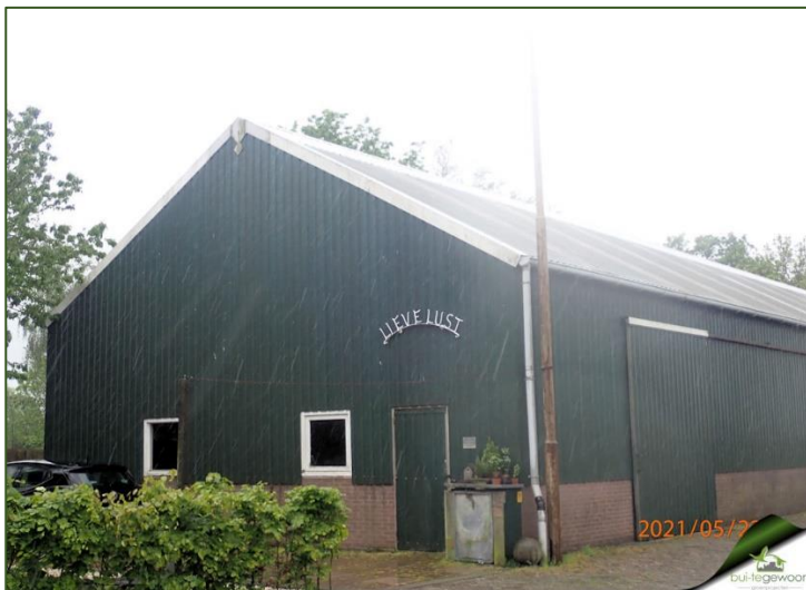
Figuur 10. Loods buitenzijde
