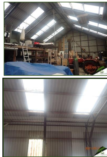
Figuur 11. Loods inpandig en afdichtende strip bij golplaat overgang wand/dak
