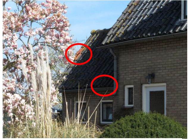
Figuur 7 Nestlocaties westzijde aanbouw bereikbaar via dakpannen en via dakgoot
