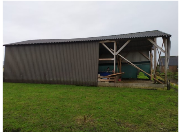
Figuur 19 Noordelijk aanzicht van de noordelijke schuur
