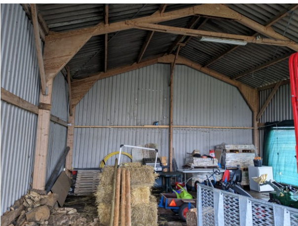
Figuur 20 Muren en het dak tegen de houten structuur
