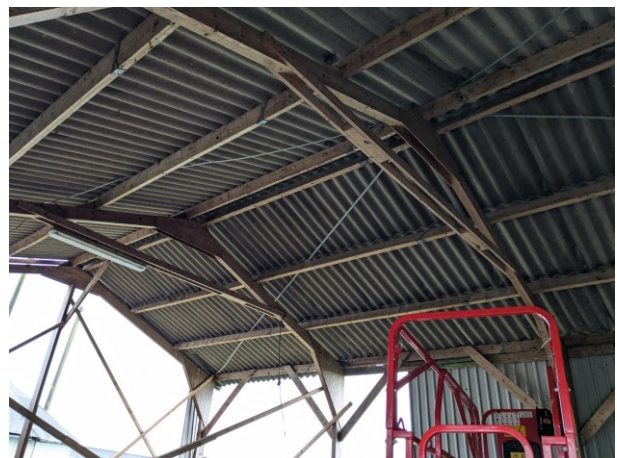
Figuur 21 Golfplaten dak direct op de houten structuur
