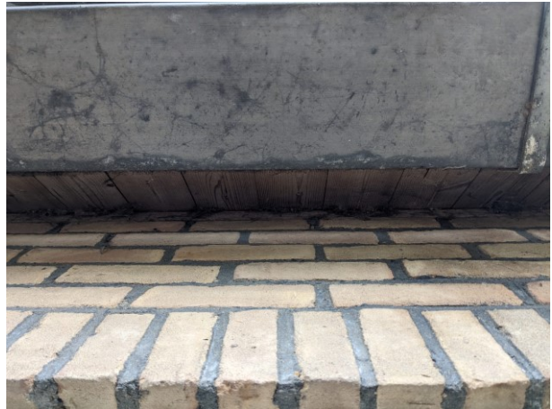
Figuur 31 Detailfoto afgewerkte dakgoot
