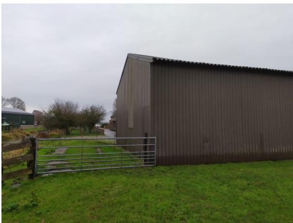
Figuur 2 Meest noordelijke schuur in het plangebied
