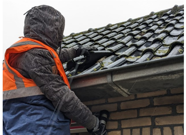
Figuur 14 Huismusnest aangetroffen onder de dakpannen
