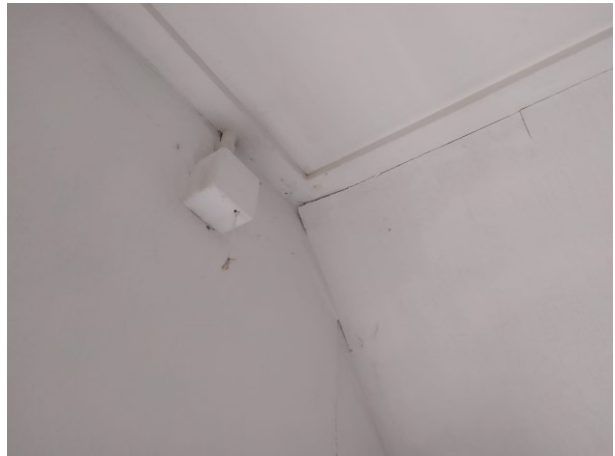
Figuur 35 Dak van binnen afgewerkt met gipsplaten
