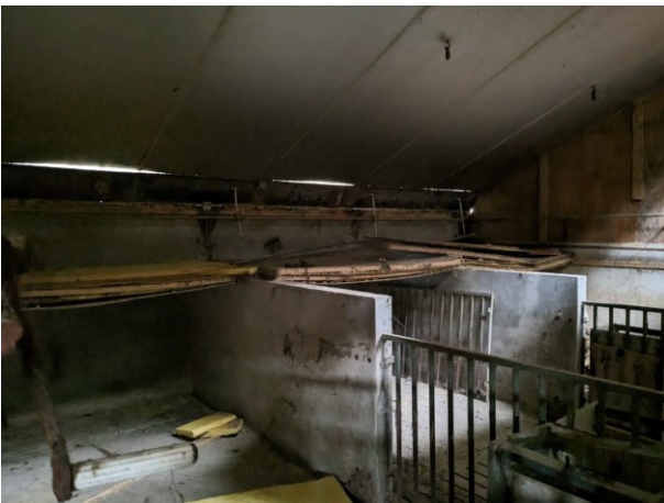
Figuur 24 Binnenzijde van de varkensschuur met metalen dakplaten en openingen bij de dakgoot
