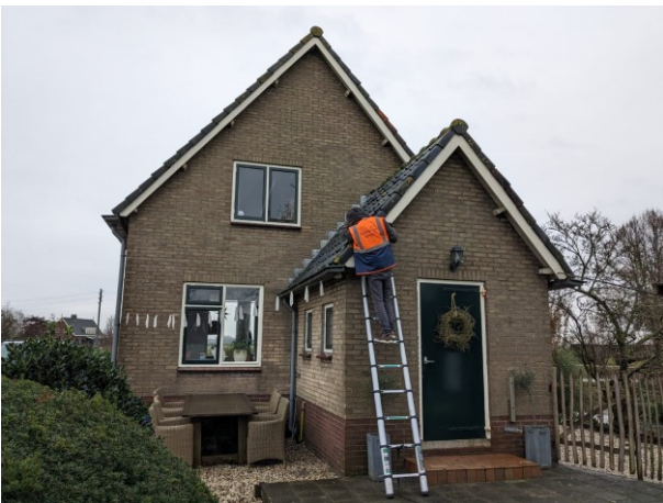
Figuur 6 Overzicht noordzijde woonhuis
