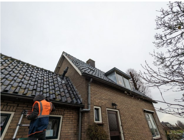
Figuur 32 Overzicht dak van het woonhuis
