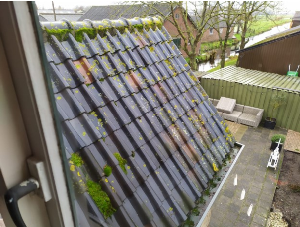
Figuur 34 Bovenaanzicht van het lage dak
