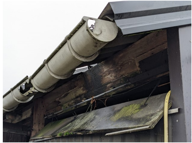
Figuur 23 Detailfoto openingen bij de dakgoot van de varkensschuur
