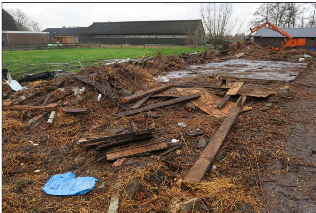
Figuur 2 Op de locatie waar de nieuwbouw loods wordt gerealiseerd is recentelijk een schuur ingestort, deze restanten dienen geruimd te worden voor de ontwikkeling
