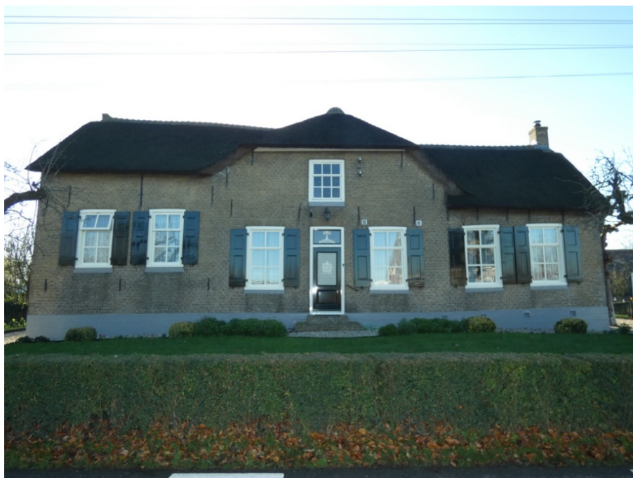
11 Overzichtsfoto voorgevel Tussenlanen 41.
