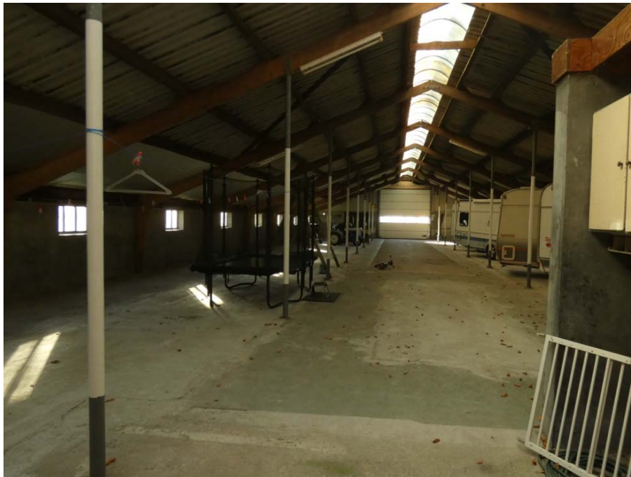
20 Gelamineerde schaarspanten met steunpilaren in het achterhuis.
