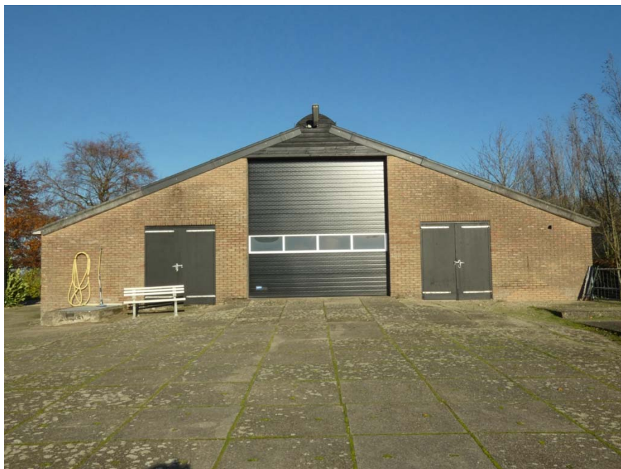
15 Achtergevel achterhuis, Tussenlanen 41
