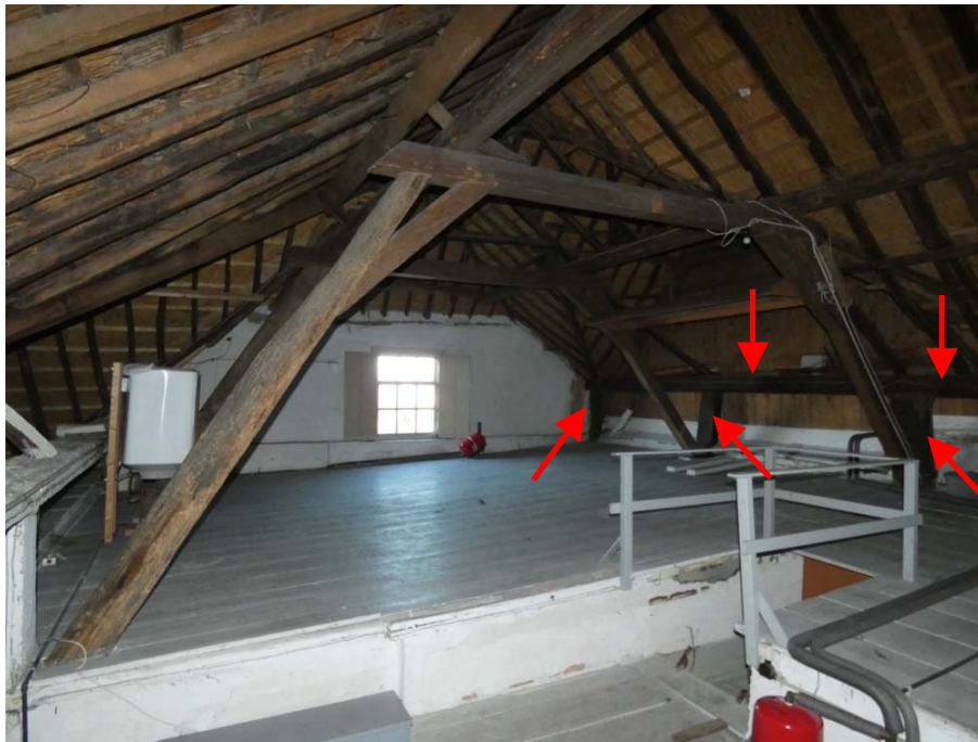
19 Ankerbalkgebinten met verticale gebintstijlen en horizontale gebintplaten (rode pijl). Daarop staat het kapsant met dekbalkjukken. Op de achtergrond het wolfseind in de kap boven het voorhuis.
