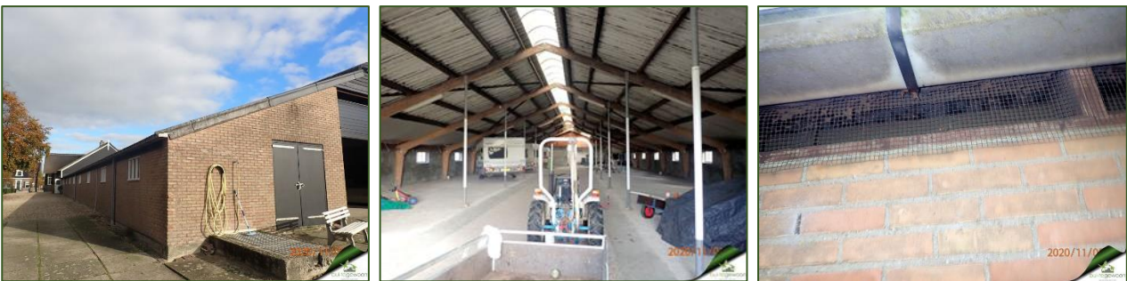
Figuur 7. Foto impressie opstal nr. 1 – aangebouwde stal drie spantvakken te verwijderen
