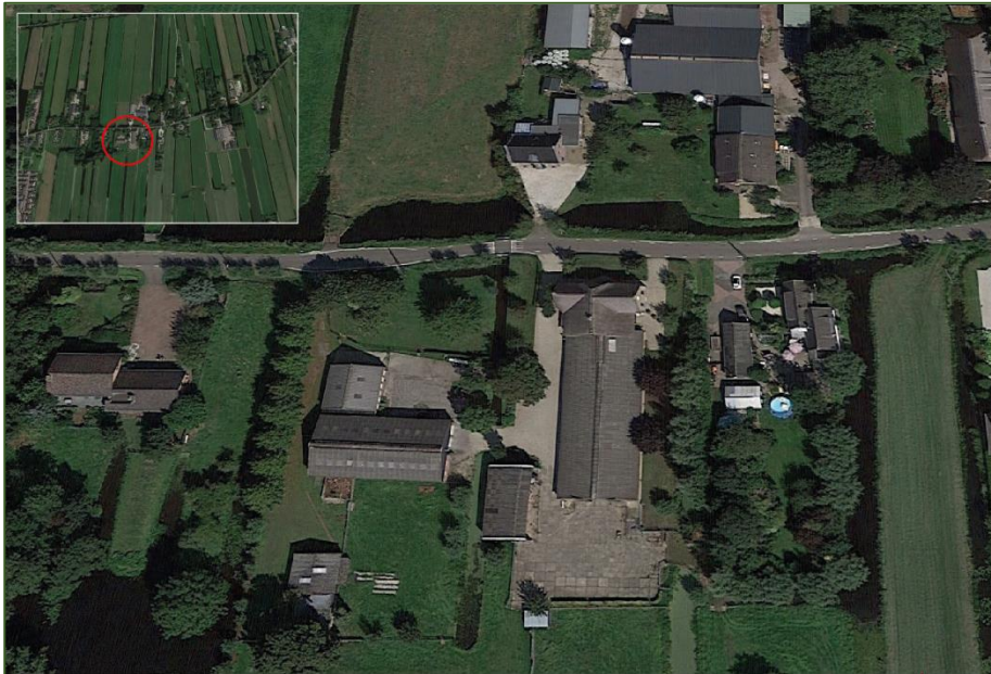
Figuur 2. Luchtfoto projectgebied (bron: Google earth)
