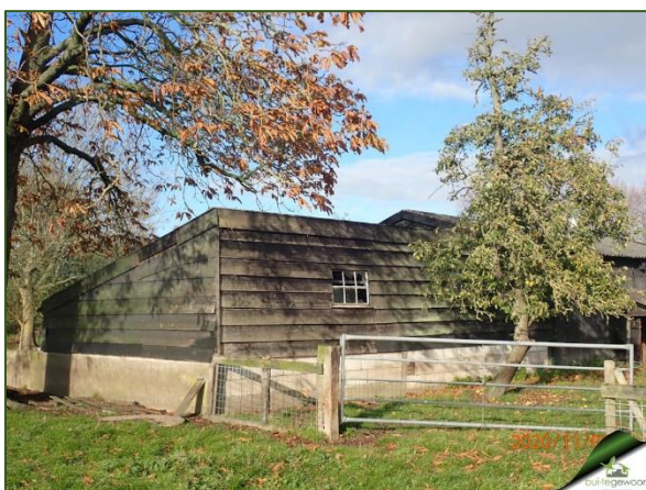
Figuur 10. Impressie opstal 5, houten schuur
