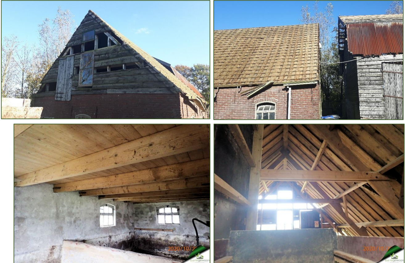
Figuur 8 Opstal 2 Bovenste foto's buitenzijde, linksonder benedenruimte en rechts bovenverdieping
