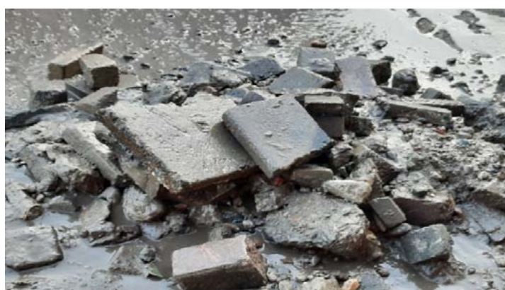
foto 20 - inspectiegat A21 [grof puin]
