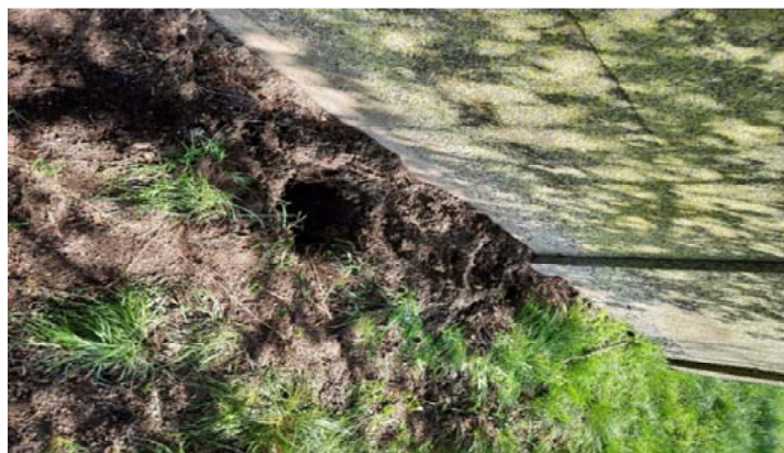
foto 26 - inspectiegat A08 (kwartslag gedraaid)
