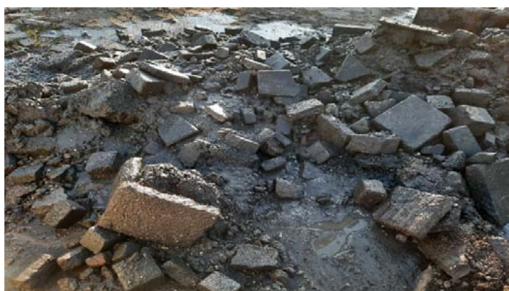
foto 19 - inspectiegat A21 [grof puin]
