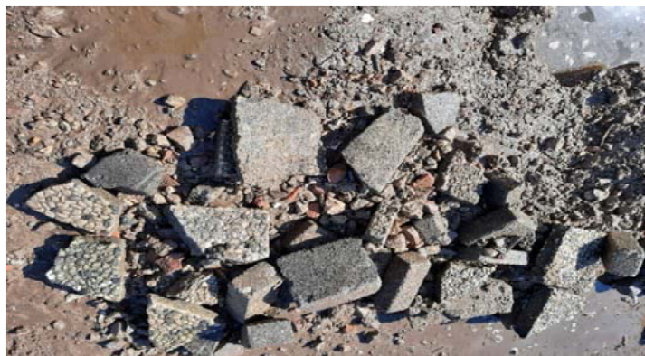
foto 18 - inspectiegat A21 [grof puin]
