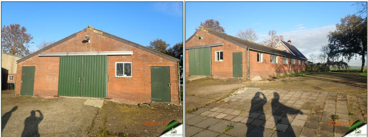
Figuur 7. Opstal 1 aan woning vast gebouwde stal
