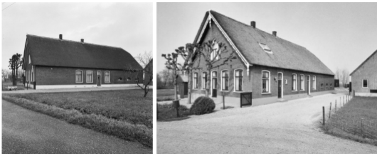
Figuur 9 aanzicht rechter zijgevel in 1975 (links) en 1994 (rechts)
