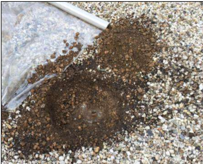
Afbeelding 9: gestaakte boring op betonverharding
