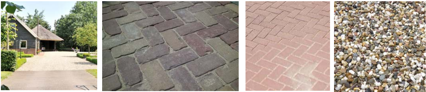
Voorerv uitgevoerd in elementenverharding, achtererf krijgt een informelere uitstraling met grasbeton en/of asfalt/grind
