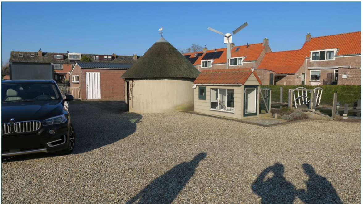
Figuur 8 Het ronde gebouw met rieten kegeldak (4) en kippenhok (5), welke binnen de beoogde ruimtelijke ingreep gesloopt worden.
