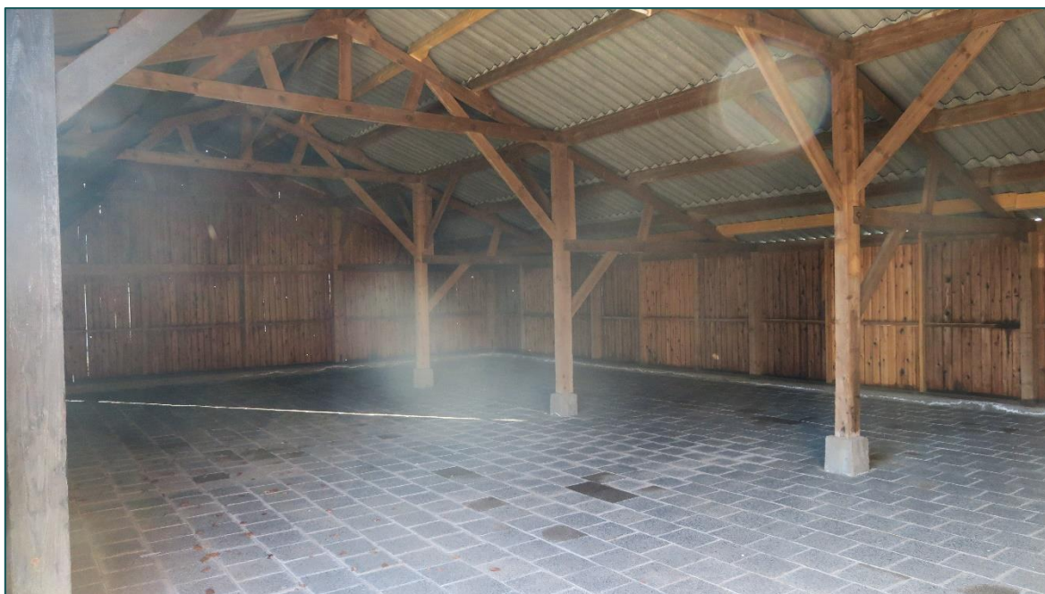
Figuur 5 Binnenzijde van de schuur (2)
