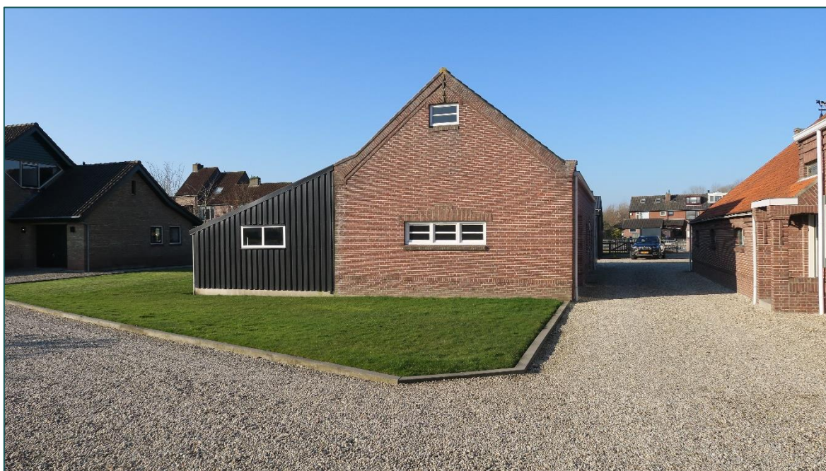
Figuur 6 De opslagruimte (3) welke binnen de beoogde ruimtelijke ingreep gesloopt zal worden.
