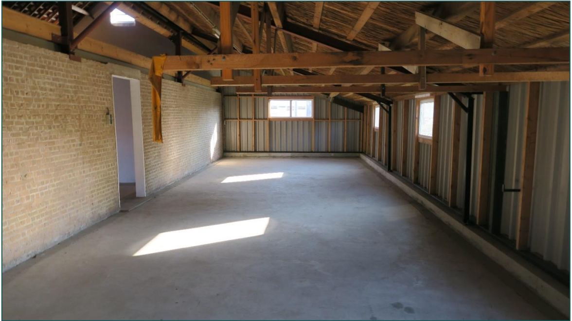
Figuur 7 Binnenzijde van de opslagruimte (3).
