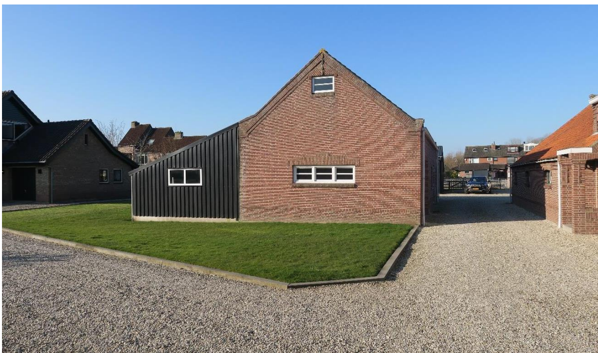
Afbeelding 6: Aanzicht schuur naast woning
