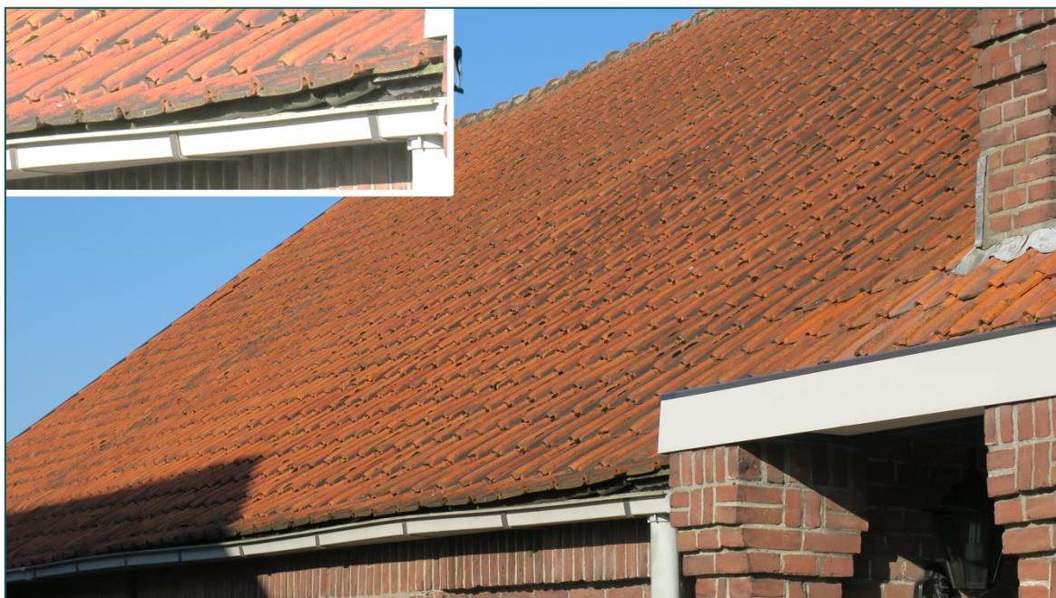
Figuur 3.2 Impressie van het dak van de te behouden woning. Wegens het gebruik van stormpannen (zeer minimale open dakruimte) en de aanwezigheid van kunststof materiaal aan de dakvoet, is uit te sluiten de huismussen in dit gebouw een nestlocatie kunnen vinden.
