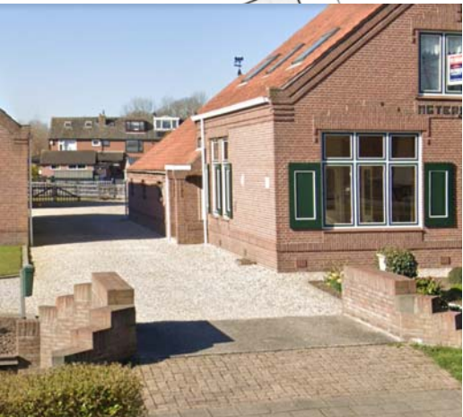
Bestaande in lijn met architectuurstijl van boerderij vormgegeven brug
