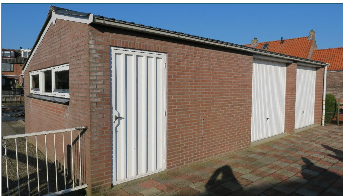
Figuur 2 De garageboxen (1) die binnen de beoogde ruimtelijke ingreep gesloopt worden.
