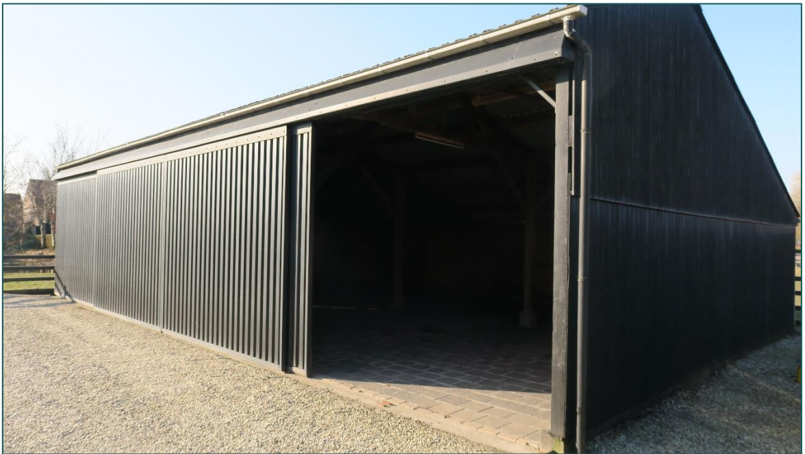
Figuur 4 De schuur (2) welke binnen de beoogde ruimtelijke ingreep gesloopt zal worden.
