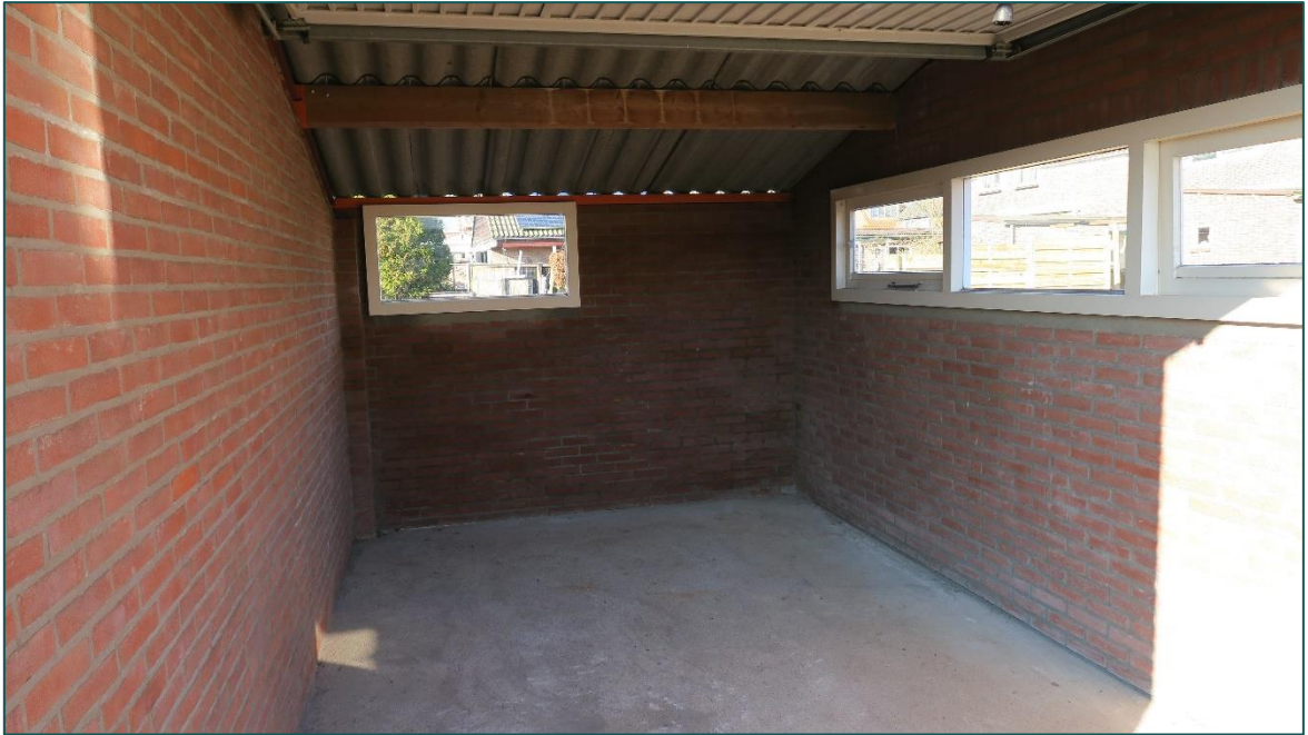
Figuur 3 Binnenzijde van de garageboxen (1).
