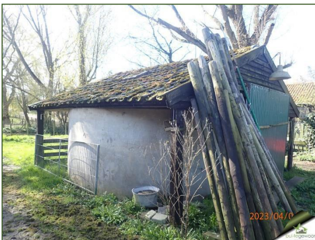
Figuur 8. Foto impressie opstal nr.c – Voormalige silo / schapenstal
