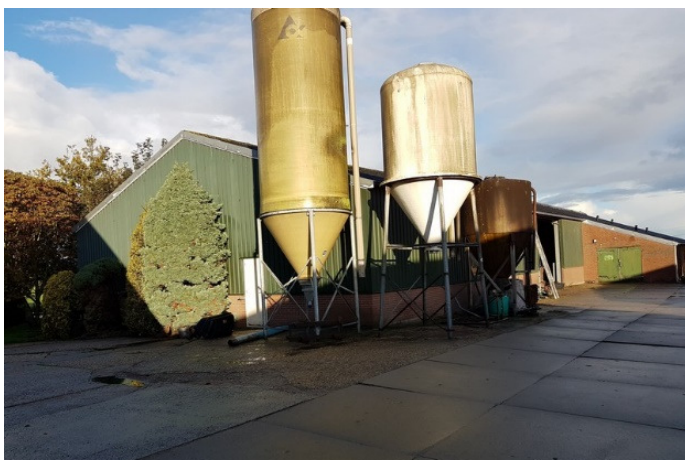
Foto 3: zuidzijde locatie, machineberging / ligboxenstal
