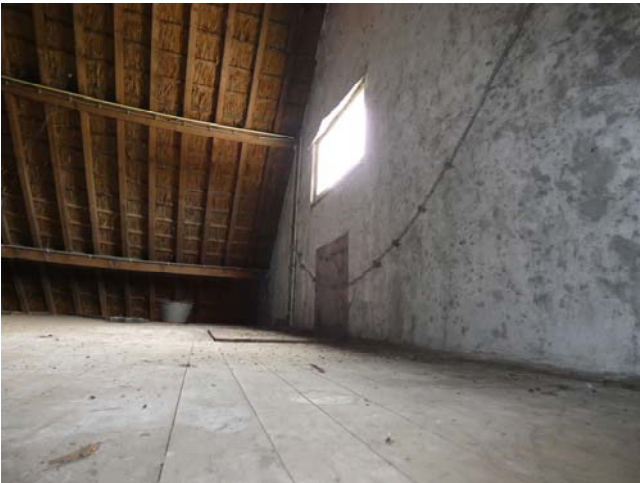
Deel verdieping. De achtergevel met het raam dat oorspronkelijk een hooiluik is geweest.
