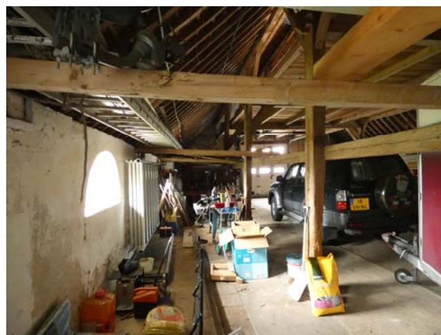
Deel begane grond met het zicht op de achtergevel. De linker zijbeuk met de gedempte mestgoot. De schoftboom en de hoofdbalken van de voormalige tilzolder zijn nog wel aanwezig.
