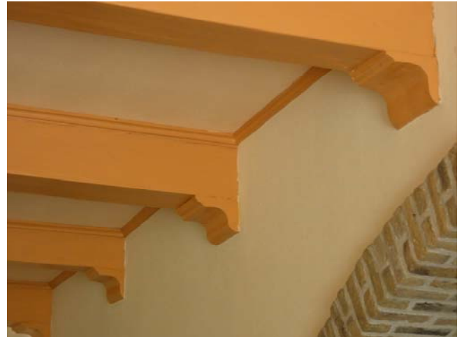
In de middenkamer bevindt zich een zolderbalklaag met sleutelstukken die uit de 17 de eeuw dateren. Deze oude balken markeren de breedte van de oorspronkelijke middenkamer.
