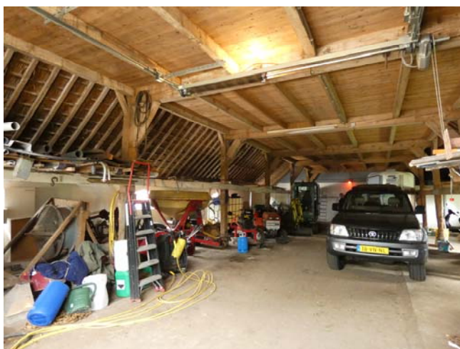
Deel begane grond met het zicht op de brandmuur. De stalruimte is erg lang en heeft een vijftal ankerbalkgebinten.
