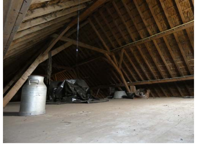
De voormalige hooizolder boven de deel. De kapspanten bestaan uit een jukspant die de vlieringbalken dragen met daarbovenop een eenvoudig schaarspant die de nokgording draagt. Alle spanten zijn van grenenhout.
