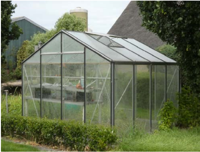
Bouwwerk; kas. De ouderdom van deze kas valt niet te achterhalen maar op een luchtfoto uit 2006 lijkt deze kas waarmeembaar.
