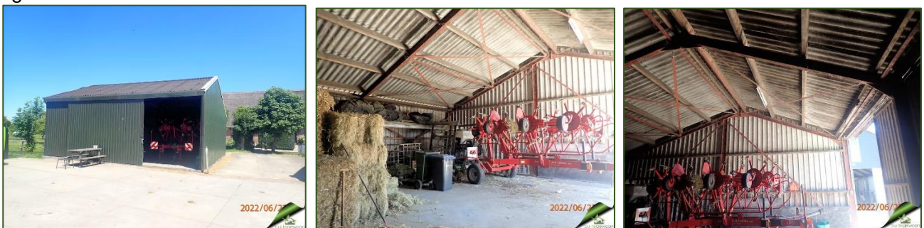
Figuur 8. Foto impressie opstal nr.2 – Schuur annex wagenberging
