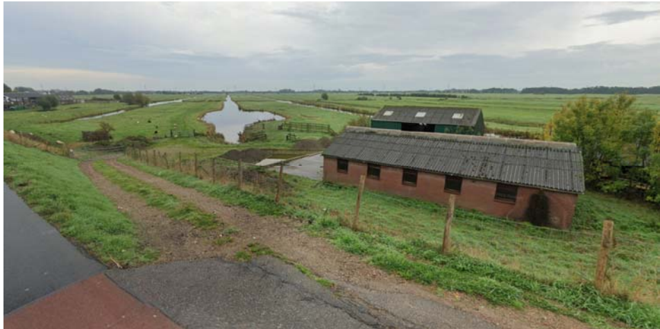
3. Zicht plangebied vanaf de dijk met bestaande vervallen opstallen en beton-verhardingen.
