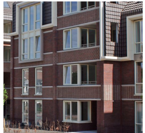
Verspringing in gevelbeeld
