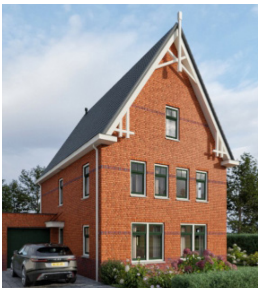
Detailering d.m.v. dakoverstek en makelaar
