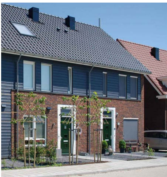
Gevels met houten geveldetailering
