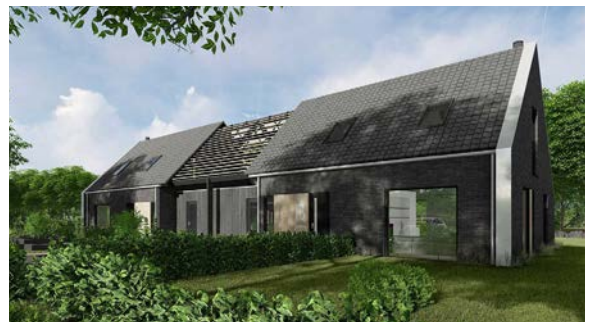
Gevels zijn van baksteen, hout of een combinatie
