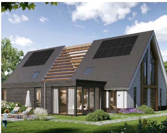
Gevels zijn van baksteen, hout of een combinatie
