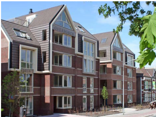
Gevarieerd gevelbeeld met passende detaillering
