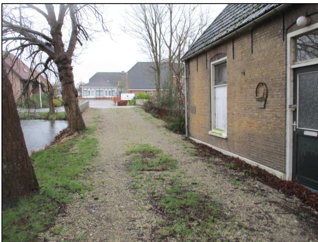
Figuur 4 Aan de Molenlaan 3 te Bergambacht is een woning met steense muren en pannen zadeldak gesitueerd. In het dak van deze woning is potentie voor verblijfplaatsen van vleermuizen en nestlocaties van huismussen.
