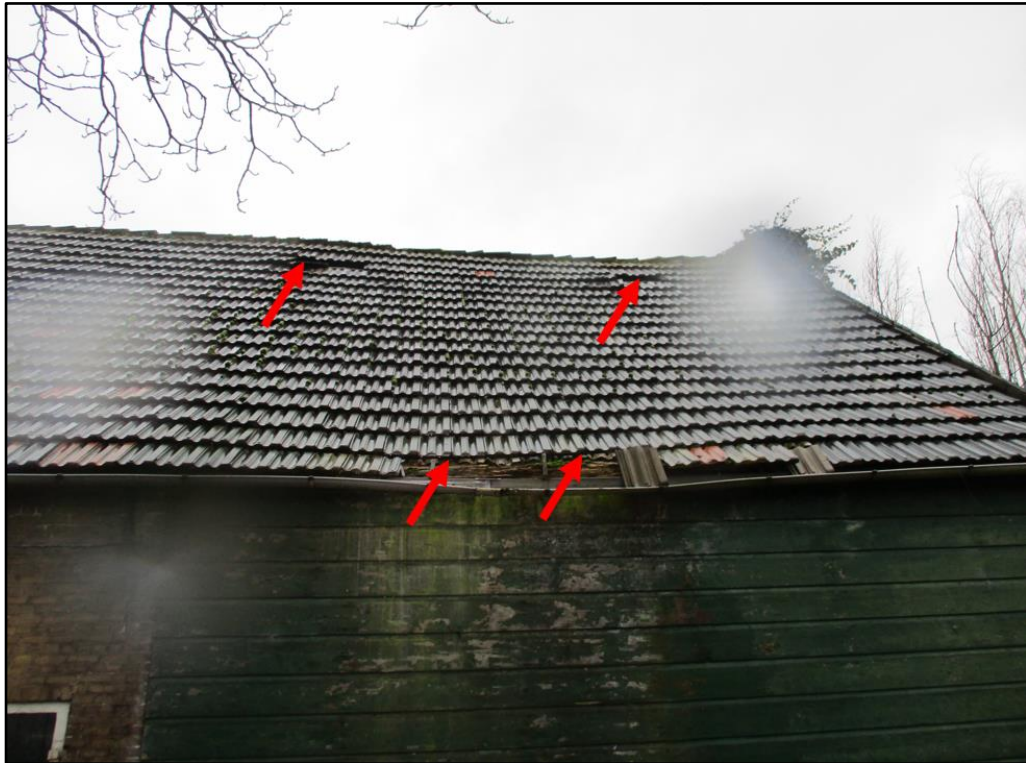
Figuur 9 Openingen in het dak die huismus toegang kunnen bieden tot de dakruimte en waar derhalve nestlocaties niet uitgesloten kunnen worden.
