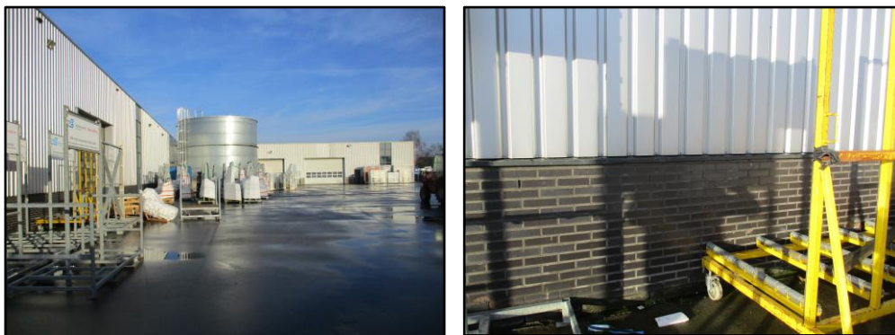
Figuur 4 Links: situatie ter plaatse van de uitbreiding van de buitenopslag. Rechts: de gemetselde muren zijn circa 1 m hoog.
