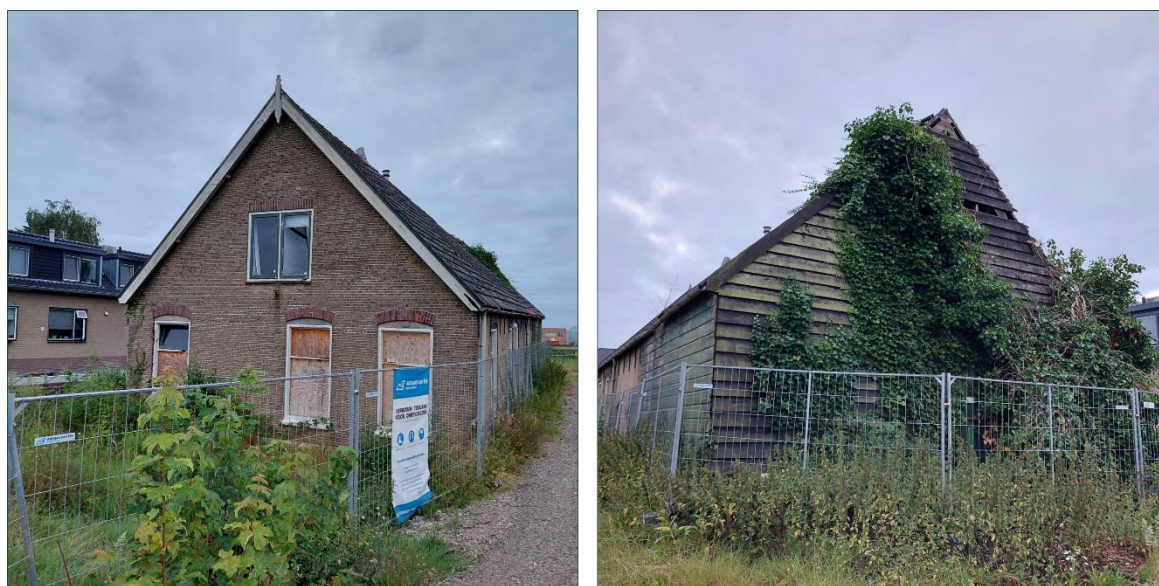
Figuur 1.2 De leegstaande woning (links) met aangebouwde schuur aan de achterzijde (rechts).
