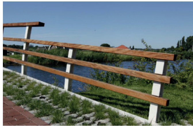
Hekwerk brug met landelijke uitstraling
