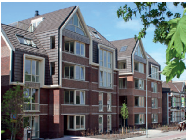
Gevarieerd gevelbeeld met passende detaillering
