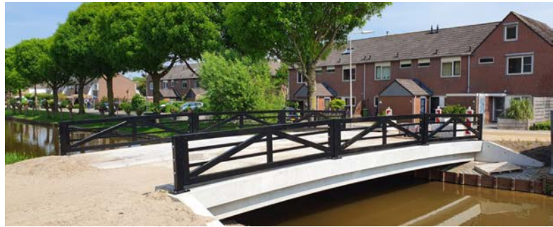
Entreebrug Molenlaan aansluitend op taluds met hekwerk landelijke uitstraling
