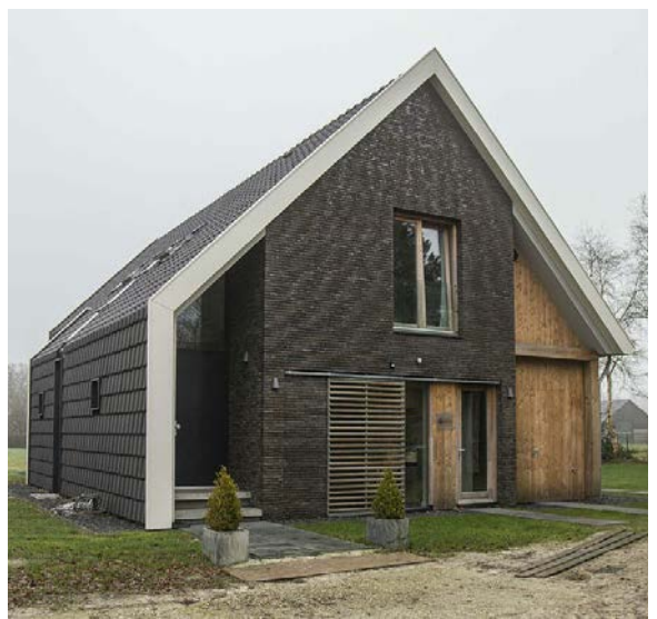
Kopgevels zijn representatief, voorzien van baksteen, hout of een combinatie
