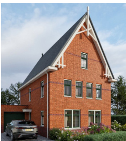
Detailering d.m.v. dakoverstek en makelaar
