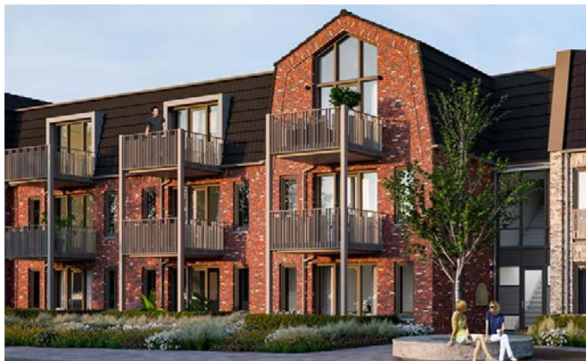
Het woongebouw bestaat uit drie bouwlagen met kap
