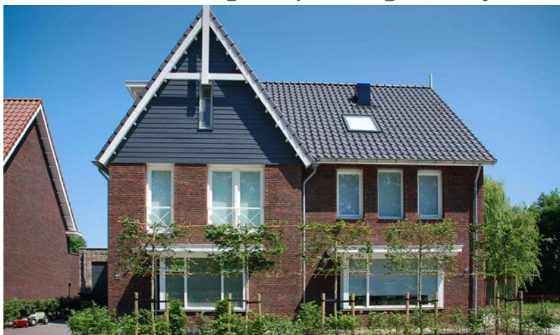
Tweekappers kunnen worden voorzien van topgevel
