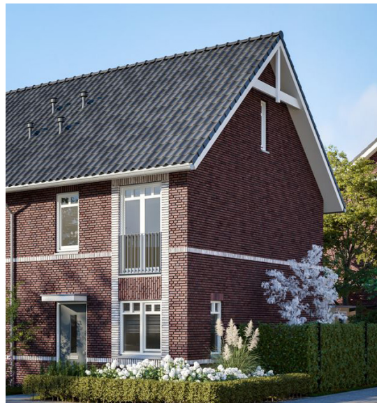
Zijgevels ook voorzien van dezelfde detaillering en materialen
