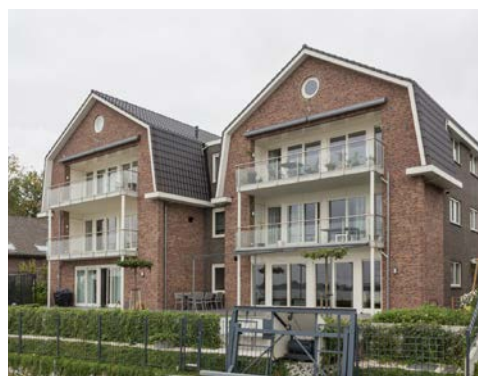
Uitkragende balkons met hoogwaardige afwerking
