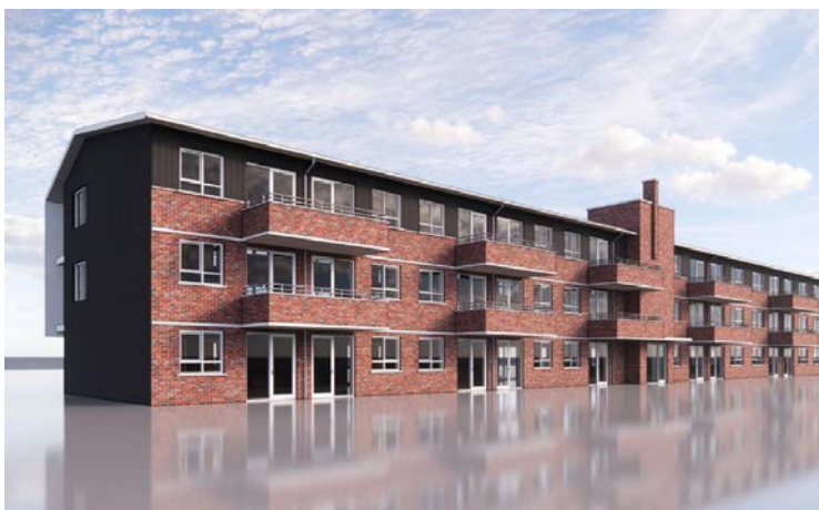
Gevel met uitkragende balkons aan binnenzijde afgestemd op grondgebonden woningen
