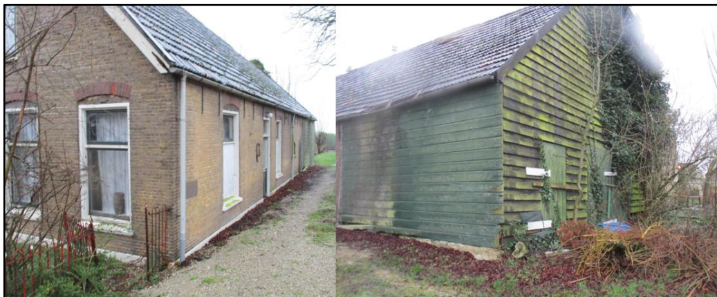
Figuur 1.2 De bebouwing op de Molenlaan 3 te Bergambacht betreft een woning en een vervallen schuur.
