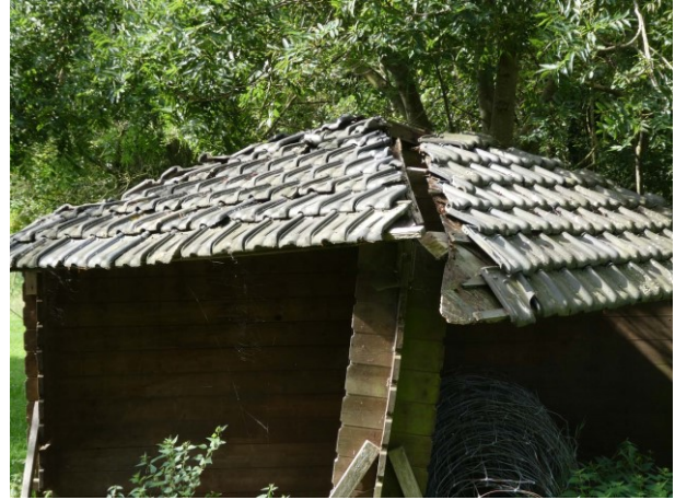
Figuur 15 Detailfoto dak van de schuur
