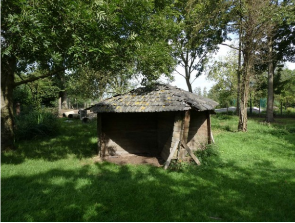
Figuur 14 Overzicht schuur in het plangebied
