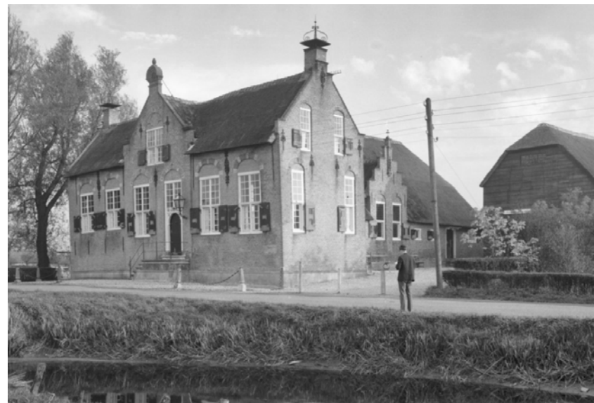
Boerderij na restauratie - 1963
