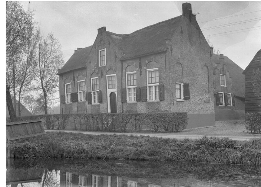
Boerderij voor restauratie - november 1937
