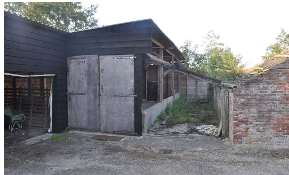
3. Kapschuren op noordwest deel van het erf
