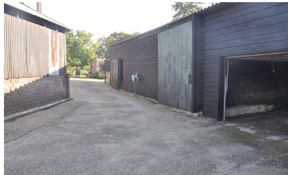
5. Doorzicht over betonerv langs schuren kijkend in zuidelijke richting
