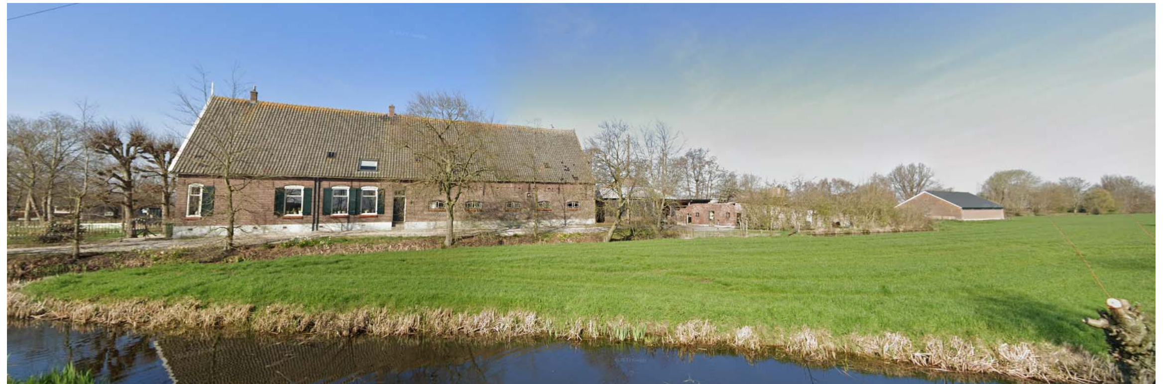
5. Bestaand ensemble met achtergelegen schuur in weiland
