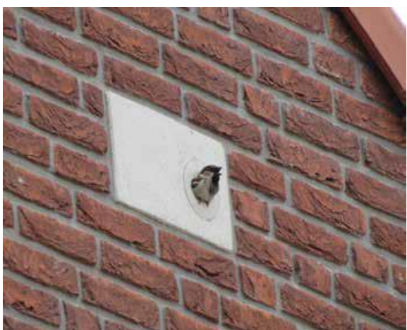
Toepassen van nestkasten in de gevel
