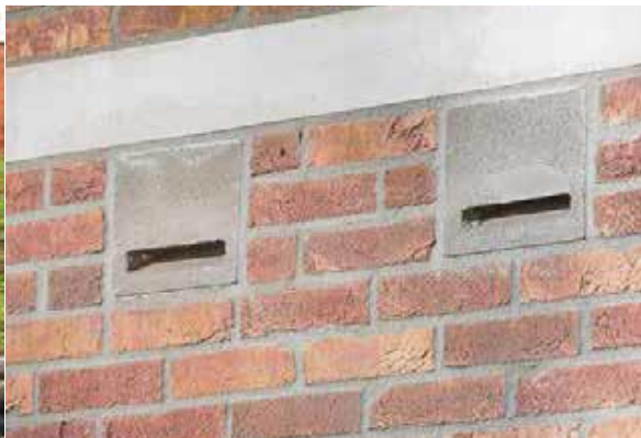
Toepassen van vleermuiskasten in de gevel
