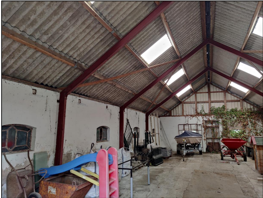
Figuur 3 De schuren op de planlocatie beschikken niet over dakbeschot. Hier is gebouw '3' te zien.
