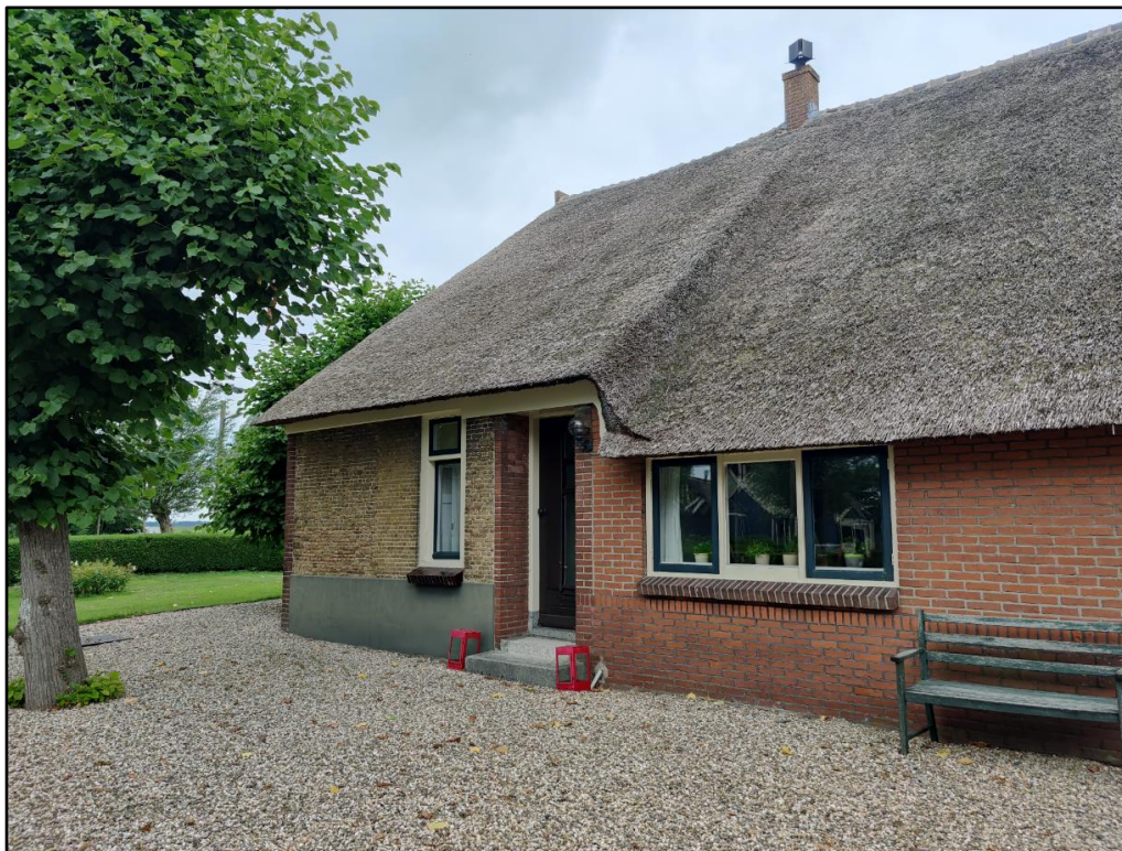
Figuur 2 De bestaande woning wordt in pandig gerenoveerd binnen de beoogde ontwikkeling.
