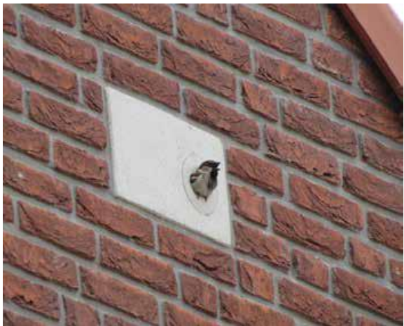
Toepassen van nestkasten in de gevel
