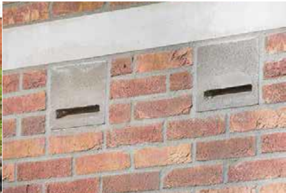
Toepassen van vleermuiskasten in de gevel
