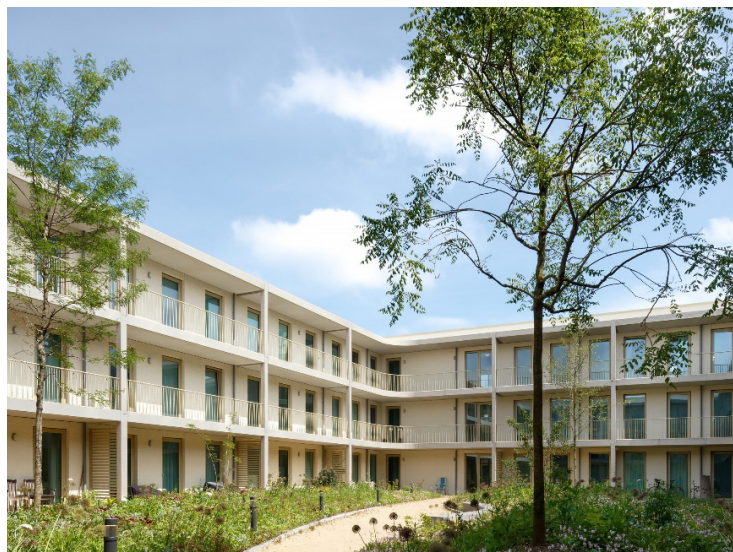
Balkons en/of galerij onderdeel van de architectuur
