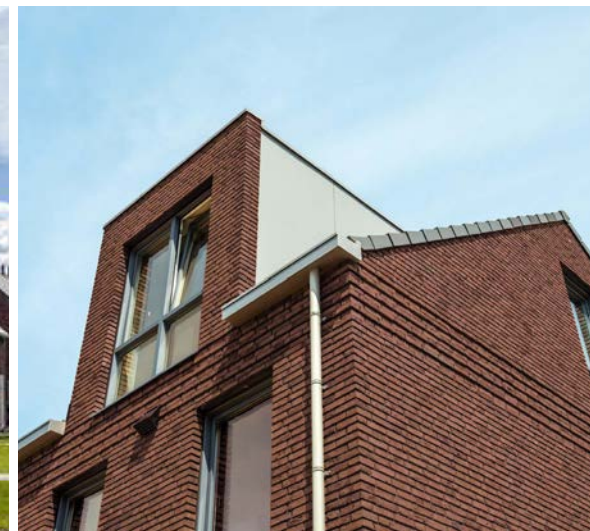
Gedetailleerde uitwerking in het mestelwerk
