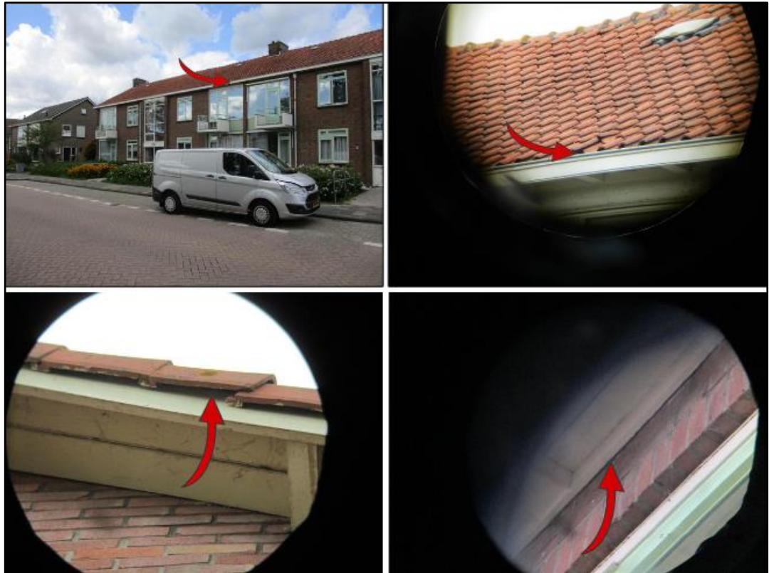
Figuur 1.3 Middels toegankelijke dakgoten, kierende kantpannen en open stootvoegen kunnen huismussen, gierzwaluwen en vleermuizen toegang krijgen tot binnenruimtes waardoor potentie voor vorengenoemde soorten niet uitgesloten kan worden.
