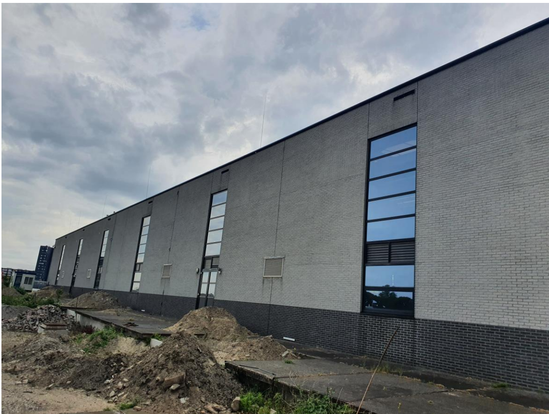
Figuur 2: Bestaande bedrijfshal, de zijde waar de nieuwe bedrijfshal tegenaan wordt gebouwd.
