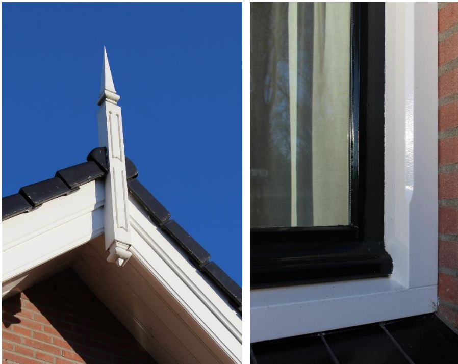
Figuur 11: Eén van de makelaars en rechts de detaillering van het kozijnhout.
