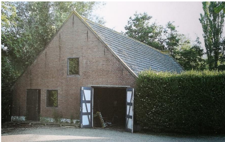
Figuur 7: Het bijgebouw vlak voor de sloop. Boven is de oorspronkelijke gevel zichtbaar.
