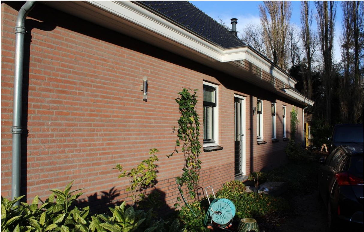
Figuur 10: De rechterzijgevel met de hoofdentree.
