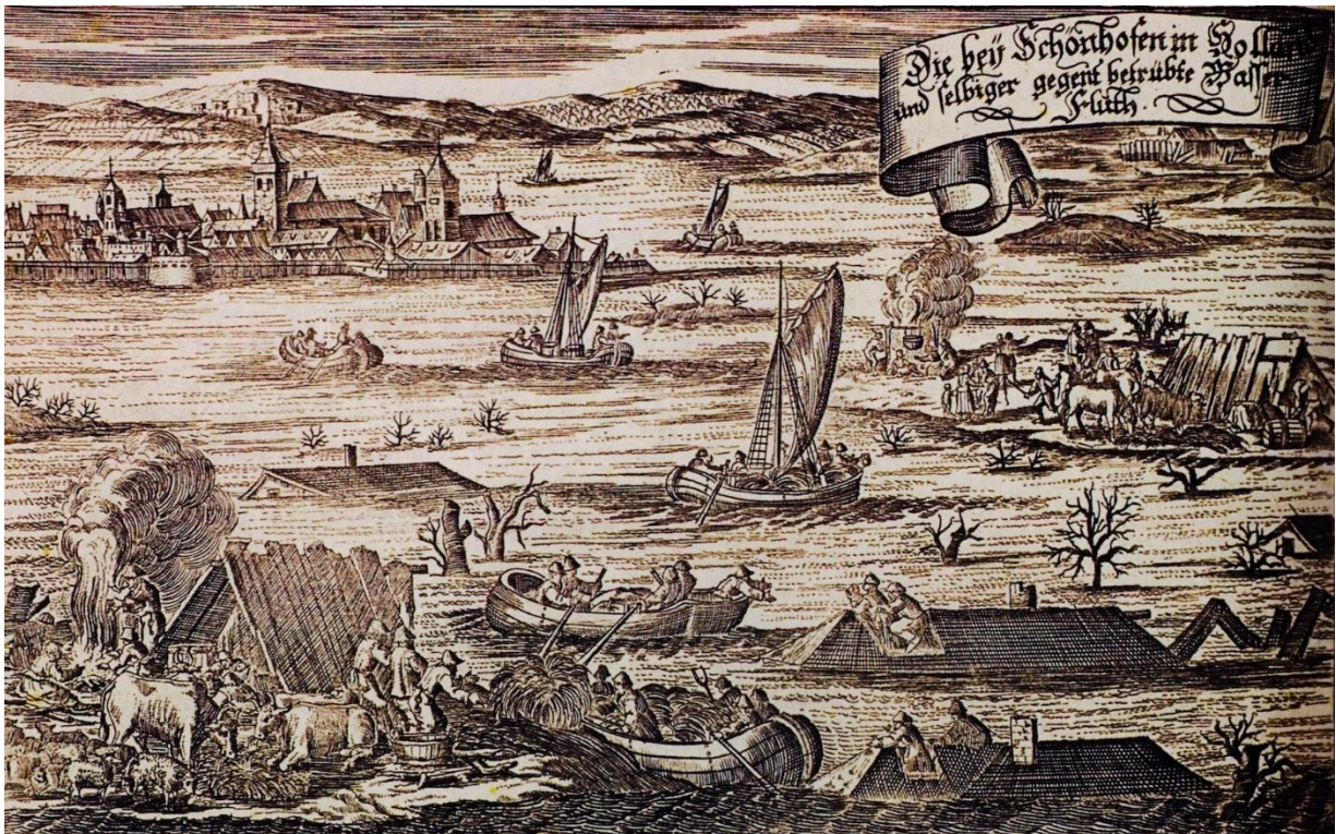
Figuur 2: Een impressie van een dijkdoorbraak nabij Schoonhoven.
