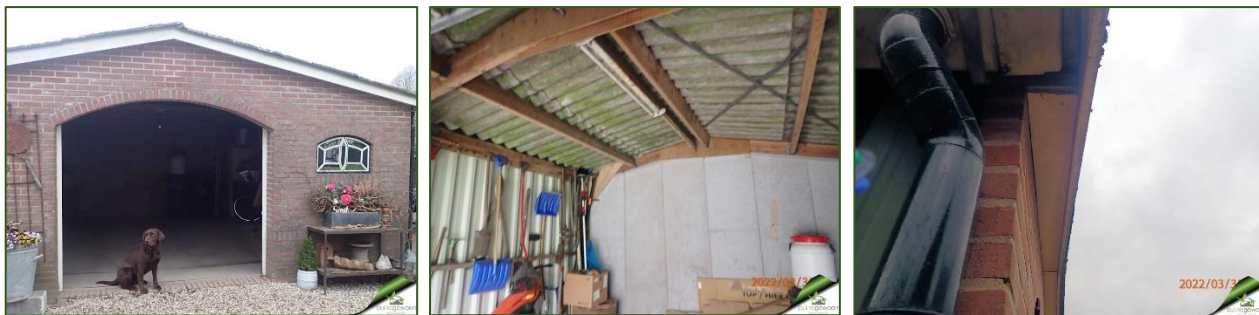
Figuur 5. Opstal 1 betreft schuur deels garage aan de westzijde van het projectgebied
