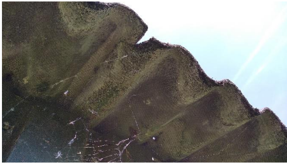
Afgebroken stukje bij asbestgat S02
