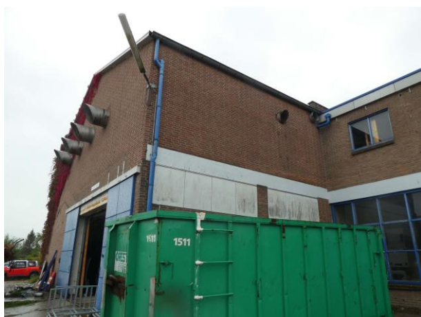
Figuur 18 Overzicht bakstenen muren
