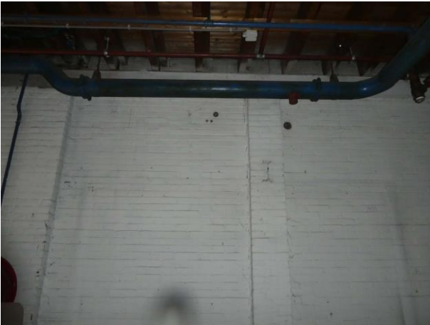
Figuur 21 Ventilatiegaten van binnenuit
