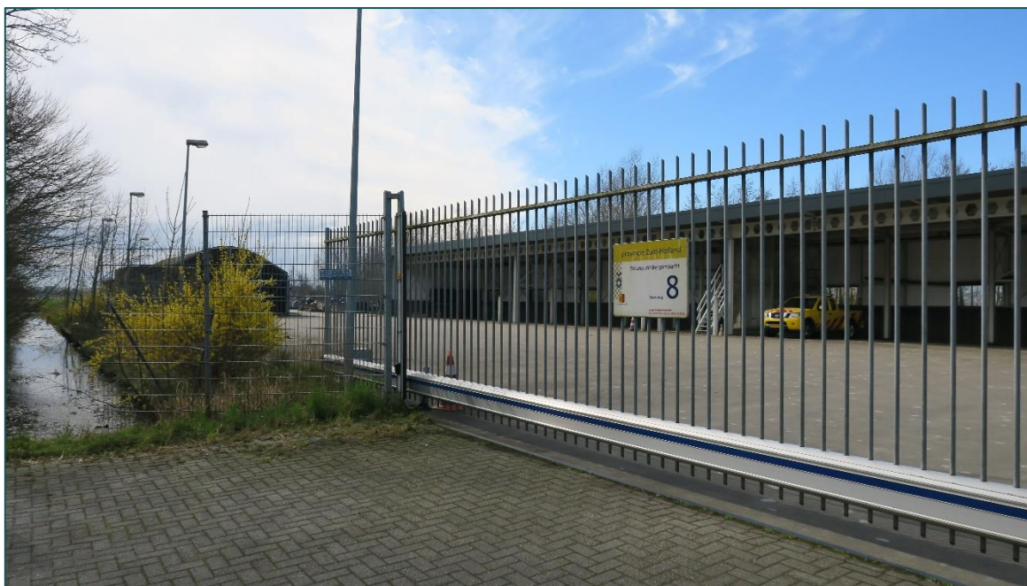
Figuur 2 Enkele opstallen welke behouden blijven en één van de watergangen welke gedempt zal worden.
